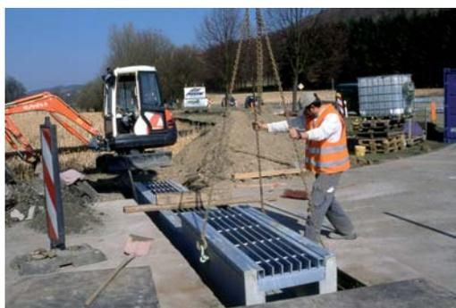
*...und Einbau einer Betonrinne mit Gitterrostabdeckung*
