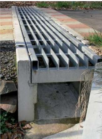
Betonrinne mit Gitterrostabdeckung aus längs verlaufenden Lamellen und vertieft angeordneten Querstreben. Dadurch ergibt sich für Amphibien keine „Brücke“ zum Überklettern
