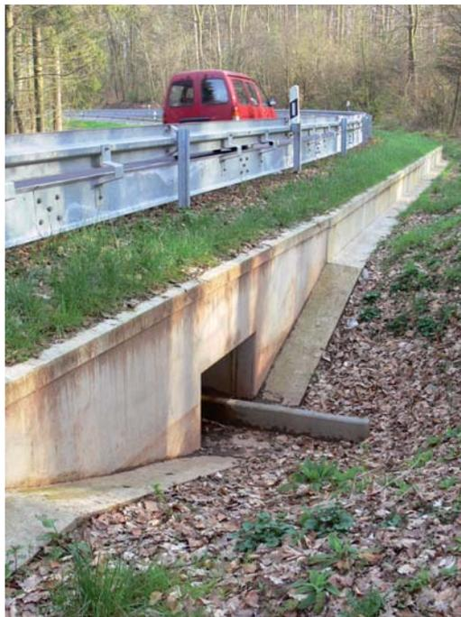
*Eine Anbindung der Durchlässe an die Leiteinrichtung über Rampen wird dann notwendig, wenn ein Höhenunterschied zu überwinden oder ein oberflächennaher Einbau der Durchlässe nicht möglich ist. Die Rampen sollten nicht zu steil (max. 1:3) angelegt werden. Die Böschung wird durch Portalelemente oder Mauer-scheiben gestützt*
