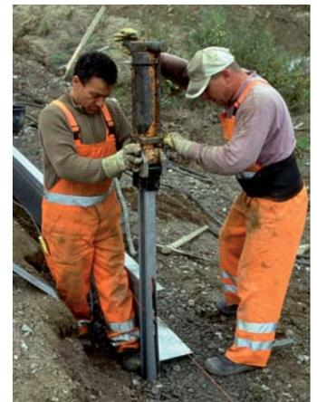
*Einschlagen der Stützpfosten für ein Leitsystem aus Stahlblech*
