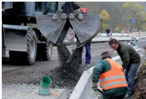
Einbau der Leitelemente aus Betonfertigteilen
