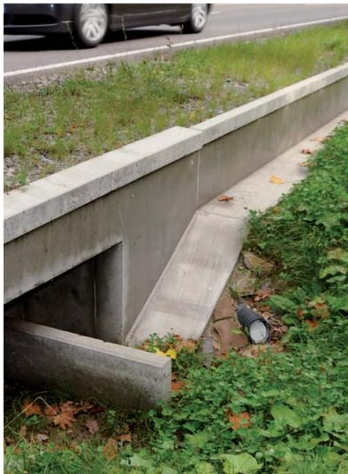
*Mäßige Bewässerung zur Funktionssicherung (Erdfeuchte) eines Amphibiendurchlasses sowie in den Durchlass hineinragende Leitblende*
