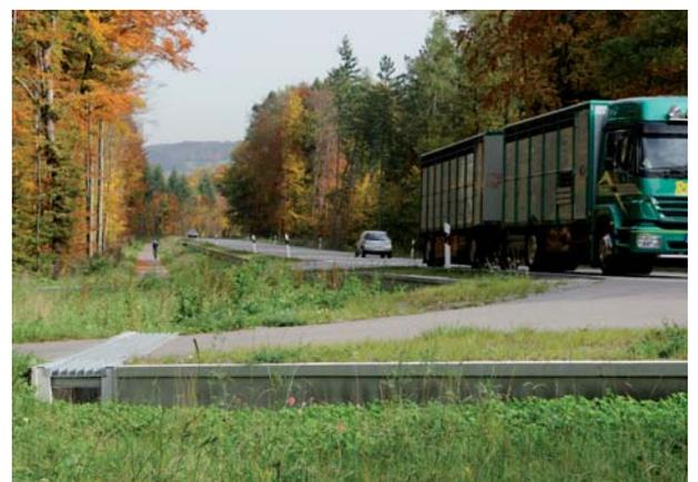
*Leitzaun und Betonrinne mit Gitterrostabdeckung*
