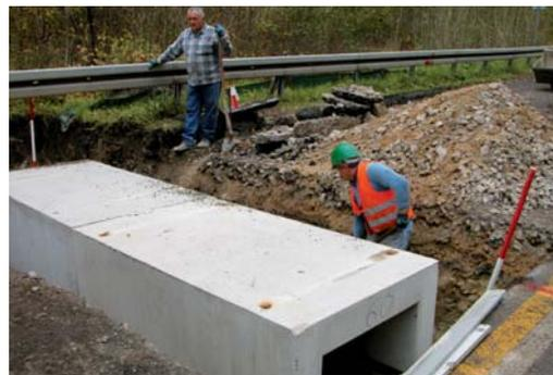
Einbau eines Amphibientunnels aus Betonfertigteilen an der Landesstraße L 1187
