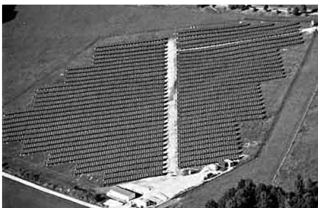
Solarpark Sonnen bei Passau
