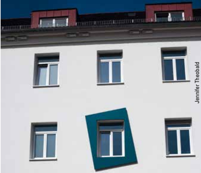
Abbildung 4: So unauffällig können Artenschutzmaßnahmen aussehen: Die sechs Mauerseglerkästen unter dem Dachtrauf eines Studentenwohnheims in Tübingen sind kaum zu erkennen. Ein direkter Einbau in den Traufkasten ist auch möglich – dann sind sie von unten so gut wie nicht mehr sichtbar. Das schräg angebrachte, türkise Rechteck bietet außerdem Unterschlupf. Mit dem richtigen Abstand von 2 bis 2,5 cm zur Wand und Möglichkeiten für Fledermäuse, sich festzuhalten, kann dahinter beispielsweise eine ganze Kolonie von Bartfledermäusen ein Zuhause finden.
