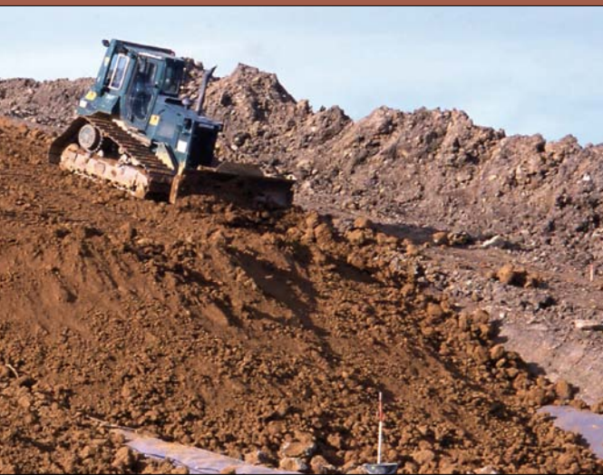
Gering verdichteter Bodenauftrag auf die Dichtungsfolie Bild: O. Ehrmann
