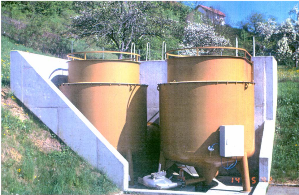
Bild 24: Die Wirbelabscheideranlage Tengen, 5 Jahre nach der Inbetriebnahme. Die beiden Abscheider FluidSep 1 mit je D = 3,0 m Durchmesser in Stahlbauweise sind an einem Hang frei aufgestellt. Im Vordergrund eines von zwei Wirbelventilen zur Abflußsteuerung.
