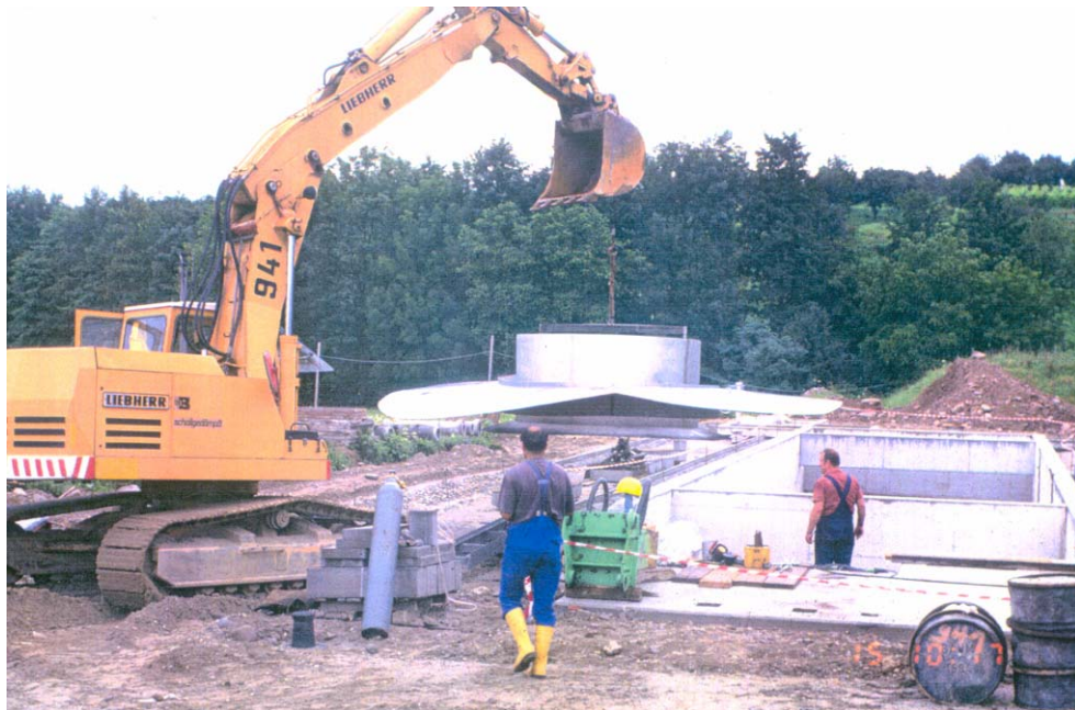
Bild 27: Die Einbauteile aus Edelstahl werden in Lauf in das Betonbauwerk eingehoben. Figure 27: Mise en place des éléments préfabriqués en acier inoxydable dans l'ouvrage en béton de Lauf
