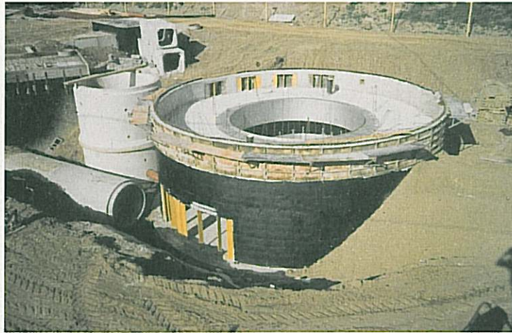
Bild 30: Der Abscheider Wittenheim-Kingsheim-Ruelisheim (WI.KI.RU) im Elsaß im Bau. Der äußere Ring mit Tauchwand und Ringschwelle aus Edelstahl ist bereits in das Bauwerk eingesetzt, das Leitblech steht provisorisch auf dem Boden des Bauwerks, weil es erst später an der noch fehlenden Bauwerksdecke aufgehängt werden kann. Die tangential einmündende Zuleitung wartet ebenfalls noch auf ihre Vollendung.
