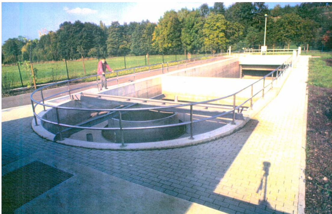
Bild 29: Ansicht der Gesamtanlage Lauf nach der Inbetriebnahme.
