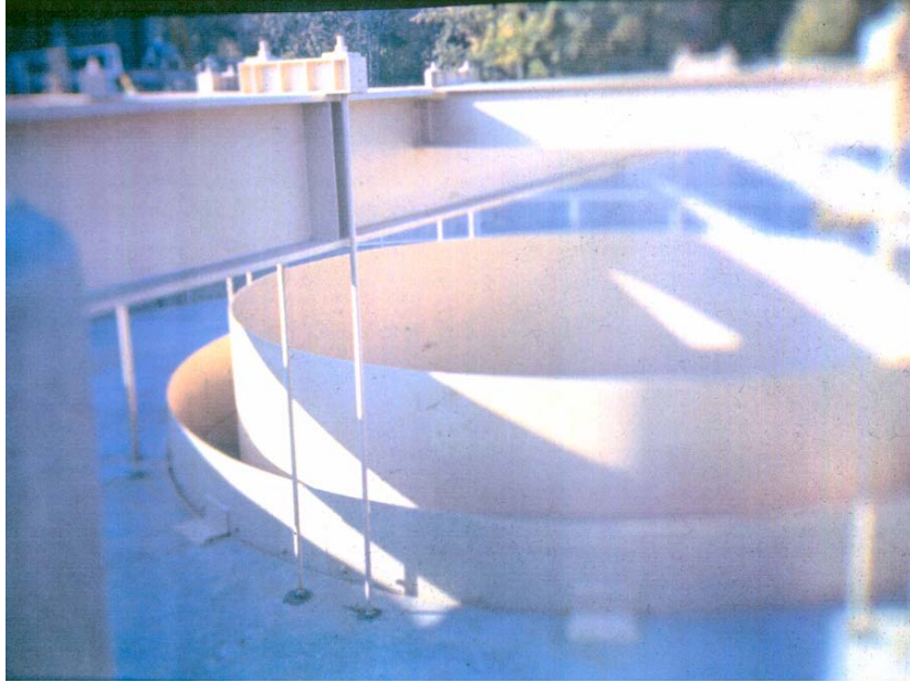
Bild 32: Ringschwelle und Leitblech eines der vier Abscheider in Decatur Lincoln Park. Der Abscheiderdeckel besteht aus einer Blechkonstruktion, die mit Hängestangen an einem über das Bauwerk gelegten Trägerrost befestigt ist (Foto: Dr. Pisano, Boston).
