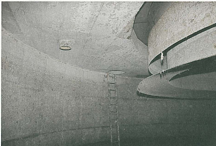
Bild 31: Innenansicht des Abscheiders Wittenheim-Kingsheim-Ruelisheim (WI.KI.RU) nach einigen Einstauereignissen. Das Wasser steigt bis zur Mündung des Belüftungsrohres (links oben). Rechts Tauchwand und Leitblech. Der Zugang zum Bauwerk erfolgt hier über luftdicht verschraubte Schachtdeckel.
