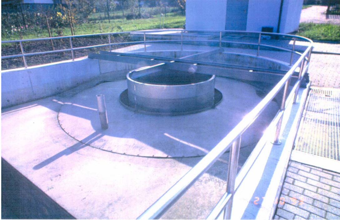
Bild 28: Der fertige Wirbelabscheider in Lauf. Vorn das Belüftungsrohr. Das "frei schwebende" Leitblech ist an quergelegten Trägern aufgehängt.
