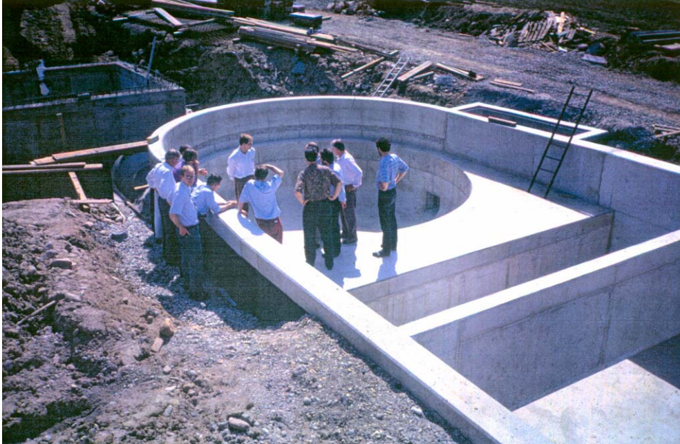
Bild 26: In Lauf bei Achern/Baden ist ein Wirbelabscheider FluidSep 3 ( D = 6,2 m) mit einem nachgeschalteten Durchlaufbecken kombiniert; hier das Bauwerk im Rohbau. Figure 26: A Lauf (dans le pays de Bade), un séparateur de type FluidSep 3 ( D = 6,2 m) assure le prétraitement des effluents avant rejet dans un bassin transit. Vue du gros oeuvre de l'installation
