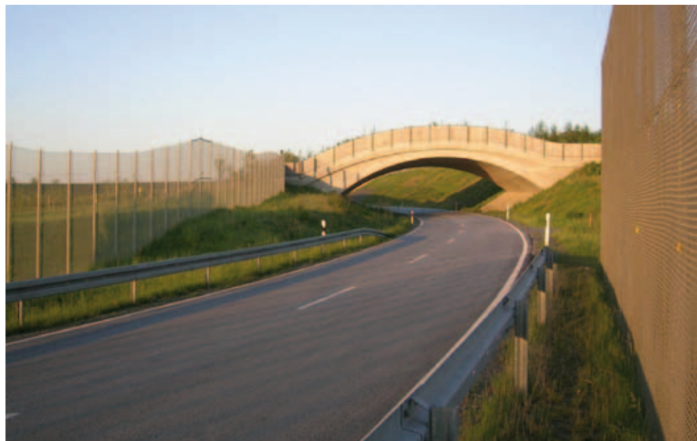
Foto 37: im Übergang zu begrünten Heckenbrücken und Grün- brücken mit beidseitigen Blind-/Irritationsschutzwänden
