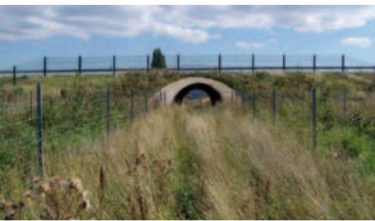
Foto 58: Begrüntes Trogbauwerk am Ende der Entwicklungspflege: Schlecht entwickelte Zielarten stehen unter Konkurrenzdruck durch Fremdbewuchs und sind als Leitstruktur nicht funktionsfähig.
