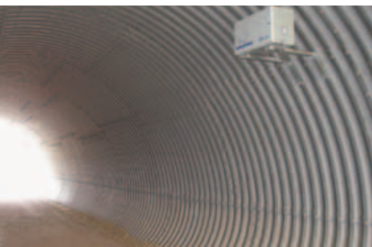
Foto 68: In einem Wellstahlrohrdurchlass wurde eine akustische Permanentüberwachung installiert, um ganzjährig die Fledermausaktivität und somit die Wirksamkeit der Querungshilfe zu überprüfen.
