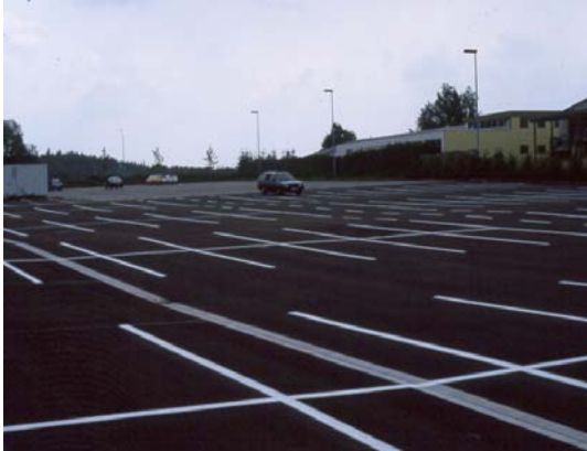
Bild 3-2: Wasserundurchlässige Befestigung bei Großparkplätzen
