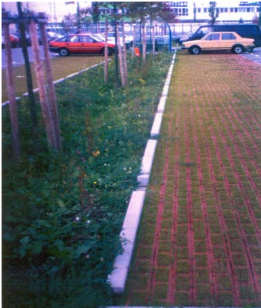
Bild 3-4: Durchlässige Befestigungen kombiniert mit bewachsenen Versickerungsmulden
