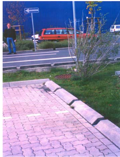
Bild 3-5: Definierte Versickerung über Rasenmulden bei wasserundurchlässiger Befestigung
