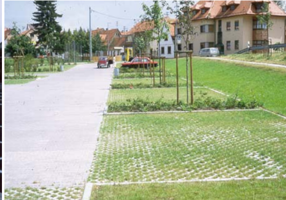
Bild 3-3: Durchlässige Befestigungen mit Rasengittersteinen
