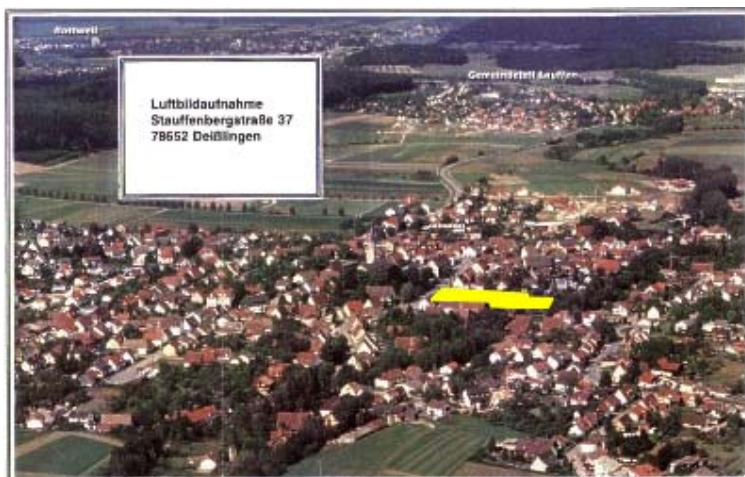
Abb. 11: Lage ehem. Uhrenfabrik Würthner & Jerger
