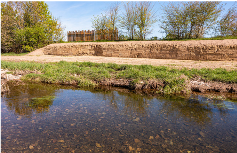
Abbildung 5-1: Angelegte Steiluferwand [RP Freiburg]
