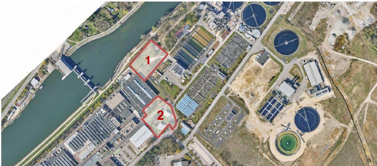
Abbildung 3.1: Luftbild der Kläranlage Steinhäule mit markierten potenziellen Flächen für eine Elektrolyseanlage
