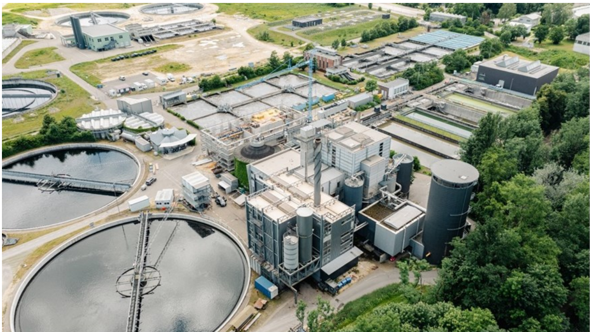
Abbildung 2.1: Luftbild des Klärwerks Steinhäule
