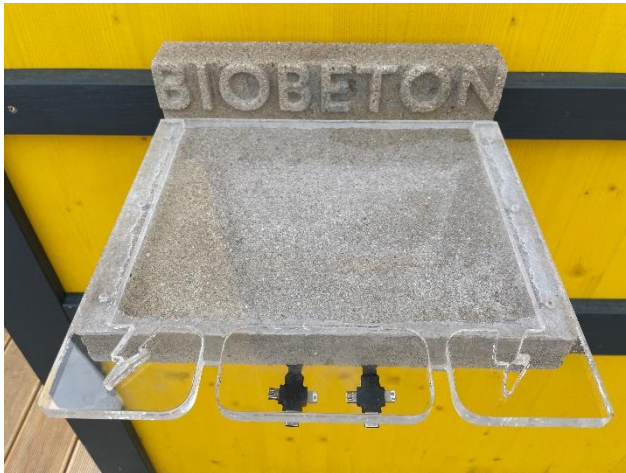
Abbildung AP5 - 4: Ladestation aus Biobeton an der Außenfassade des Toilettengebäudes
