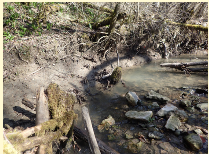
Im Prallhang findet eine leichte Ufererosion statt und es bildet sich eine tiefe Fließrinne.
