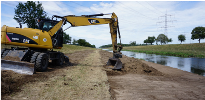
Anschließendes Andecken mit dem Baggerlöffel
