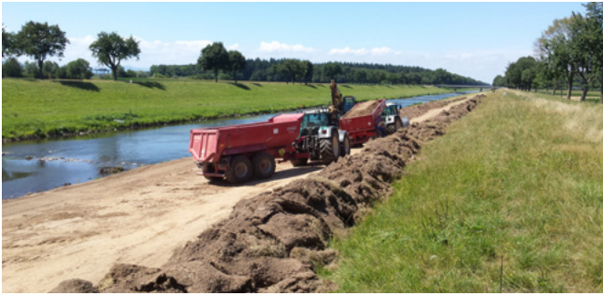
Vorlandabtrag und zwischengelagerte Rasensoden
