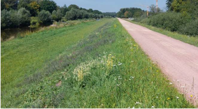
Wiederbegrünter Damm und Vorland bei Köndringen [RP Freiburg]
