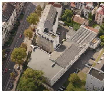
Abbildung 47: Existierende PV-Anlage auf dem FZI HoLL (15 kWp), es existierten weitere nicht genutzte Dachfläche
