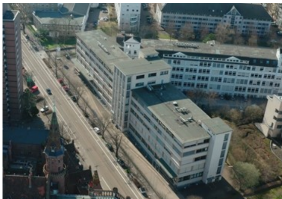
Abbildung 53: Technologiefabrik hat noch das größte ungenutzte Potenzial, es soll nach einer Dachsanierung zukünftig gehoben werden
