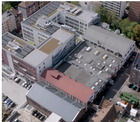
Abbildung 50: Das Brauereidach bietet noch größeres ungenutztes PV-Potenzial, Belegung für einen Teil des Daches ist bereits in Planung
