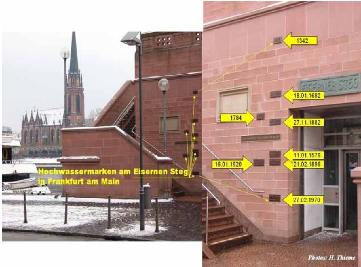
Abb. 1: Hochwassermarken am „Eisernen Steg“ in Frankfurt am Main
