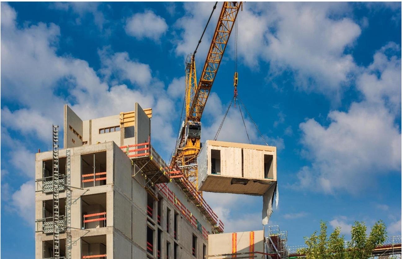
Abbildung 13: Ein Hochhaus in modularer Bauweise entspricht dem Prinzip des „Zirkulären Bauens“. Es kann zum Beispiel zurückgebaut werden um an anderer Stelle wieder aufgebaut zu werden, oder in seine einzelnen Werkstoffe zerlegt werden. (Quelle: Jarama/stock.adobe.com)
