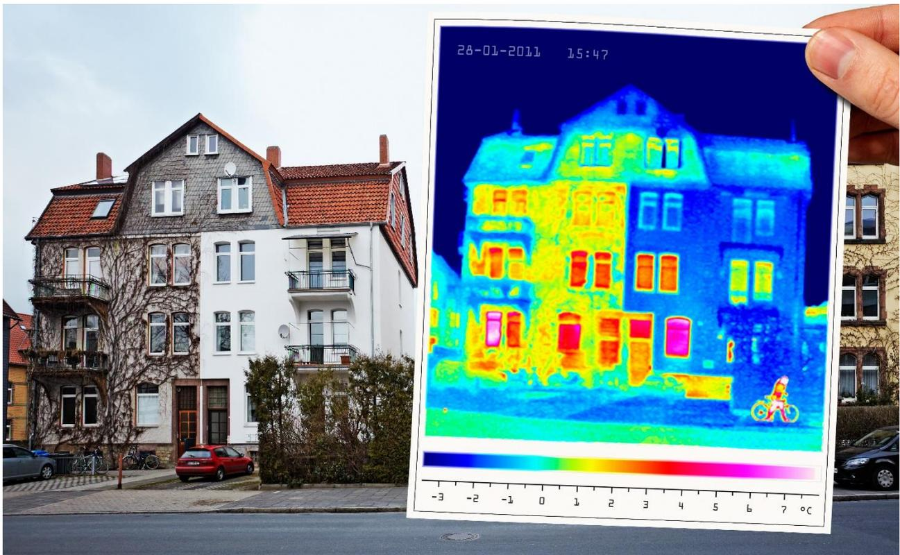
Abbildung 12: Halb neu isoliertes Gebäude mit vergleichendem Thermobild (Quelle: Ingo Bartussek/stock.adobe.com)
