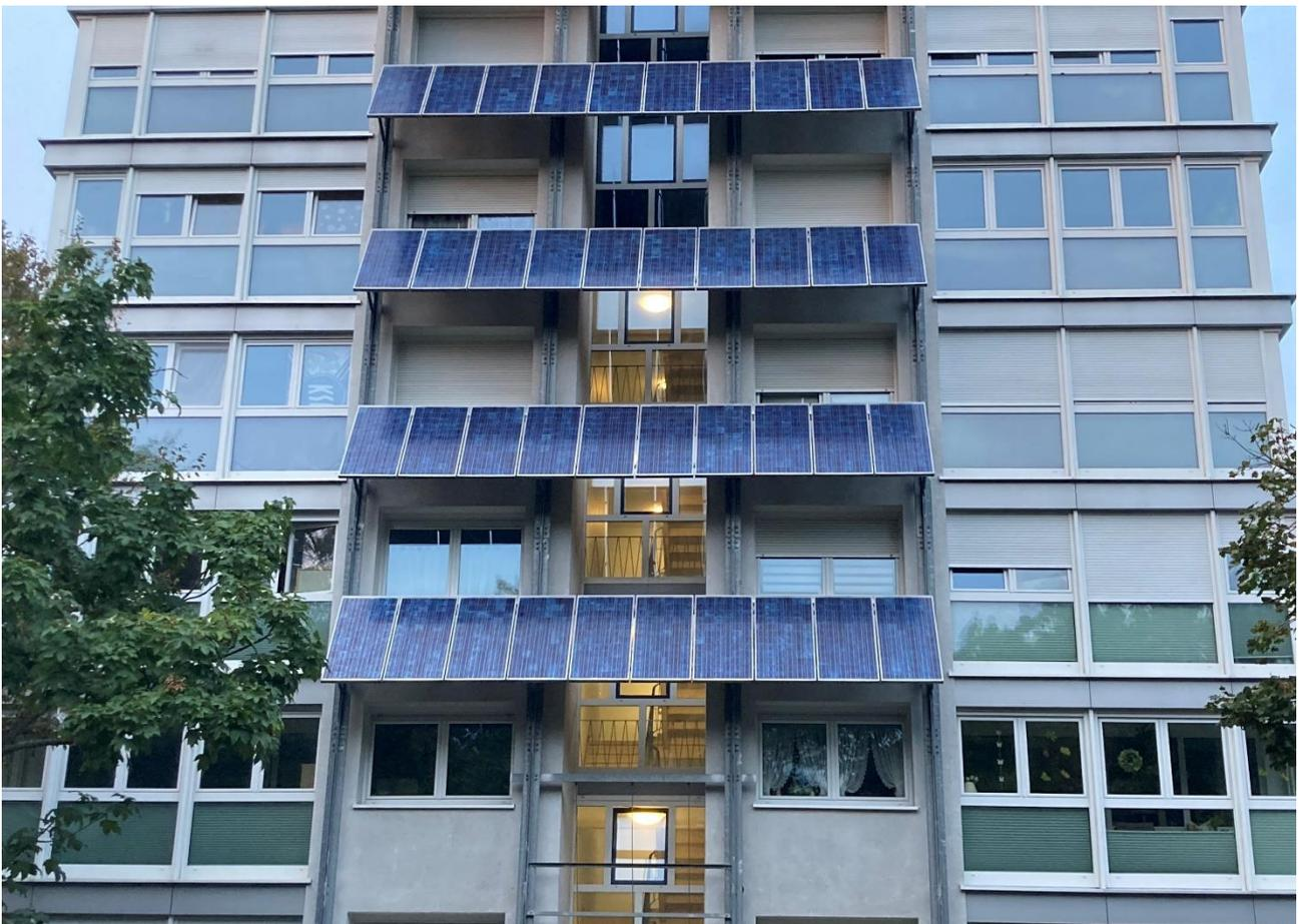
Abbildung 8: Photovoltaikmodule an einer Fassade eines Gebäudes. (Quelle: A. Matt, LUBW)
