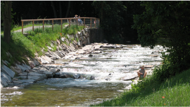
Senkrechte Ufer an einem Begleitweg sind Gefahrenstellen [RP Freiburg]
