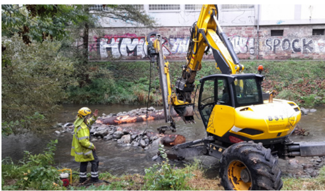
Fixierung mit Stahlankern [RP Freiburg]
