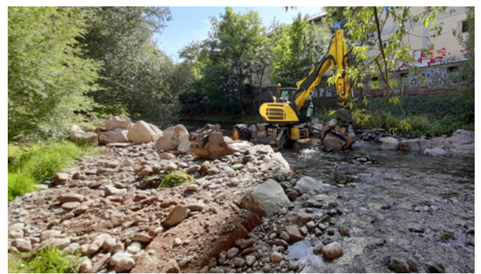
Bau des Strömungstrichters [RP Freiburg]
