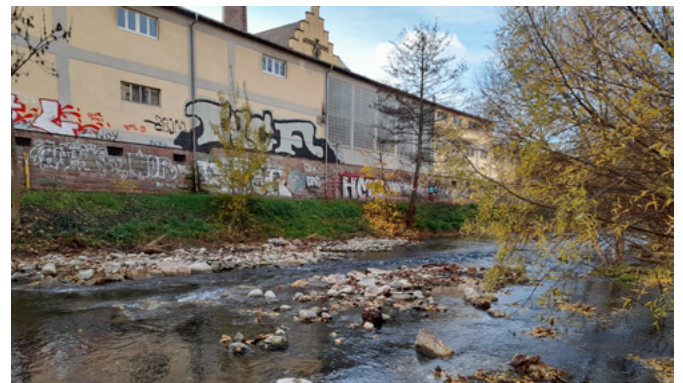
Strömungstrichter von Oberstrom [RP Freiburg]
