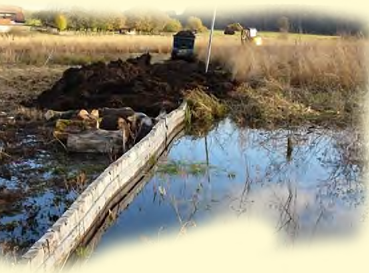
Spundwand zur Wiedervernässung
