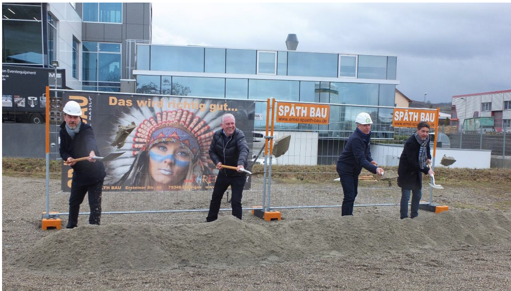
Abbildung 2: Spatenstich für den Parkplatz und des PV-Carports bei Eltroplan Engineering GmbH. Bildquelle: focusEnergie
