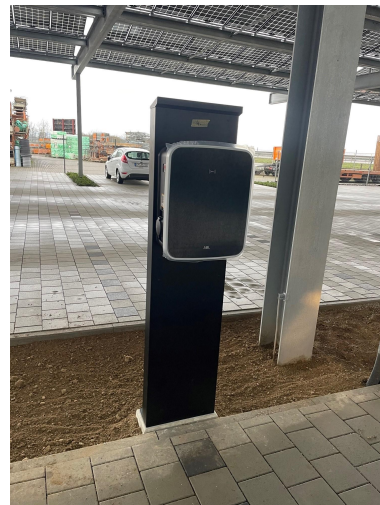
Abbildung 6: Ladepunkte unter dem PV-Carport (Quelle: Ralf Bickel)
