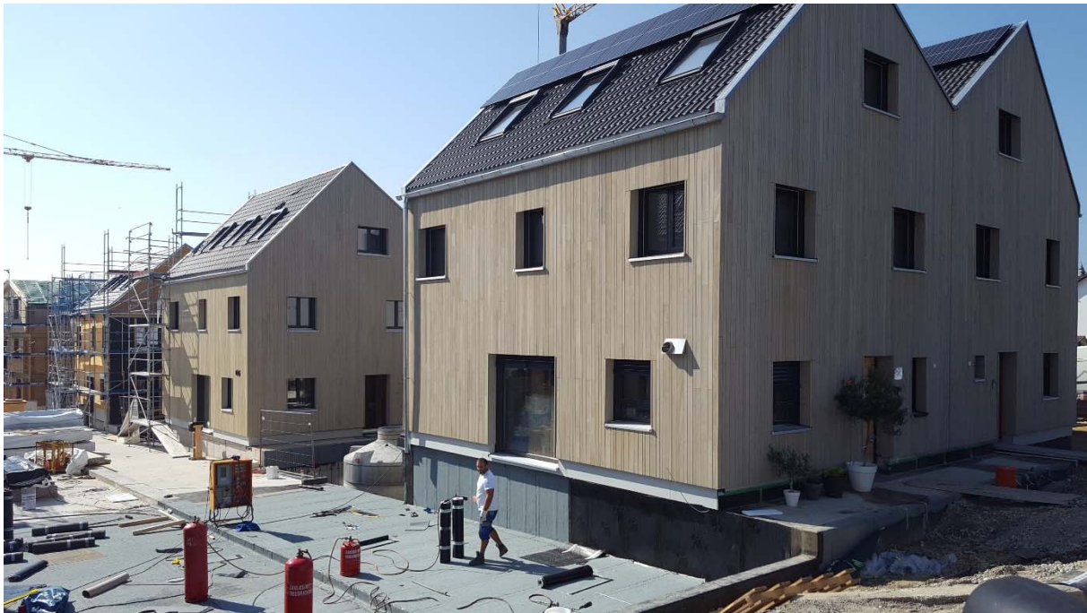
Abbildung 6: Baustelle und erste bezogene Häuser im September 2020
