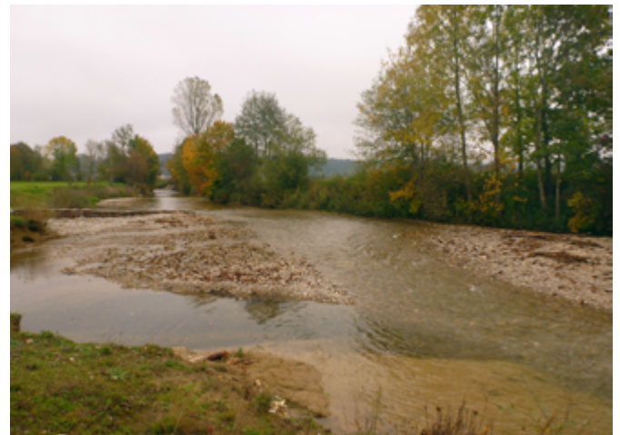
Wirkung einer überströmbaren Buhne gegen die Fließrichtung an der Echaz [LUBW]
