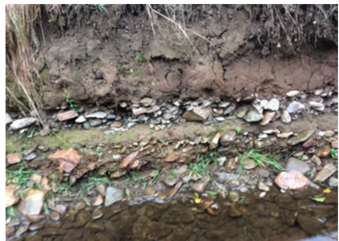
Bindige Deck- und Zwischenschichten reduzieren die Erodierbarkeit [LRA Sigmaringen]
