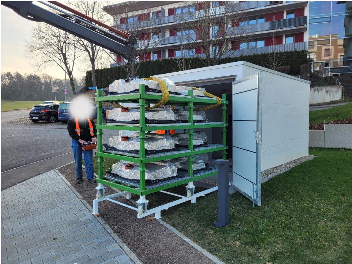
Abbildung 17: Stapeln der Batterien mithilfe eines Bordladekrans
