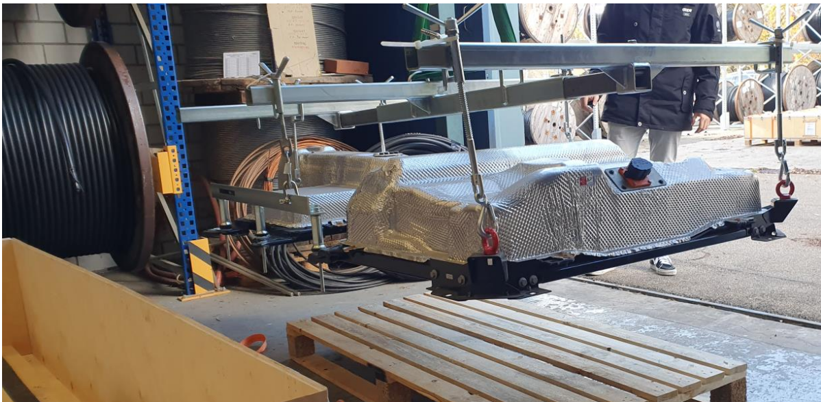
Abbildung 11: Entladen einer Batterie mit der Traverse
