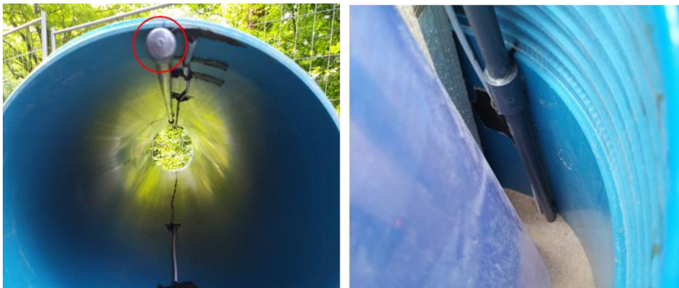
Abbildung 190: Einbau der Pt100 Referenzsensoren am Außenrohr und Platzhalterrohr für die Sensorkette im Ringspalt (rot markiert links) und Platzhalter und Sensorkabel im verfüllten Ringspalt (rechts).
