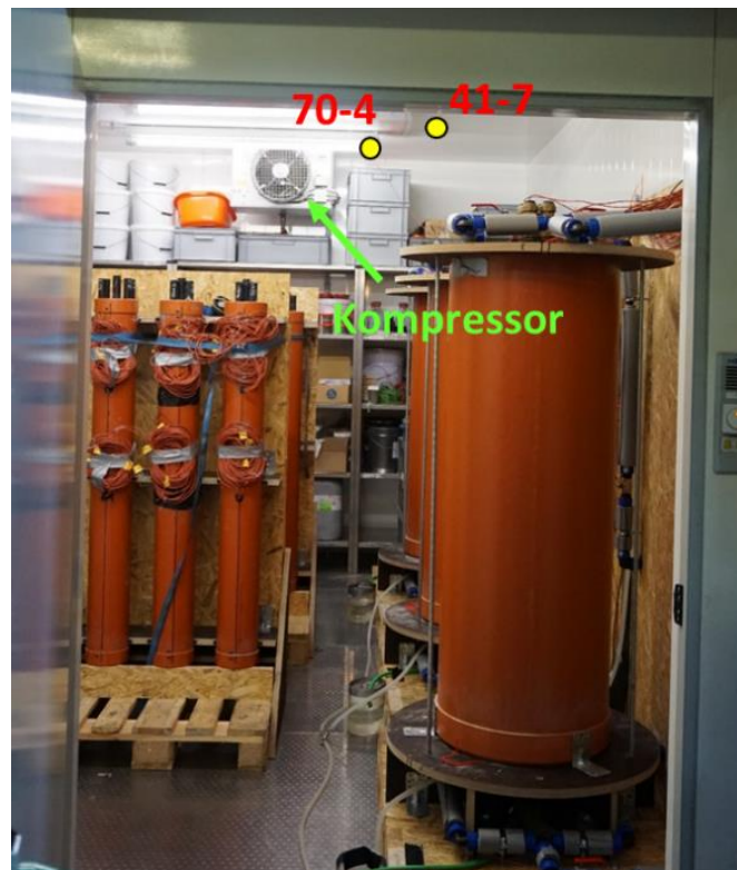
Abbildung 138: Temperatursensoren im Kühlraum
