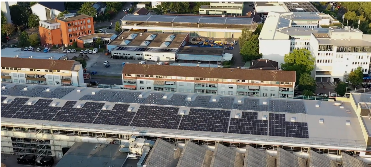
Abbildung 11: PV-Anlage auf Halle 8 - Vogelperspektive
