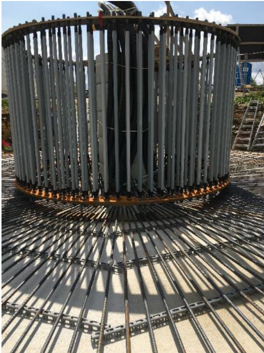
Abbildung 35: Der Ankerkorb wurde um den Zentralschacht aus mehreren Einzelteilen gebaut.
