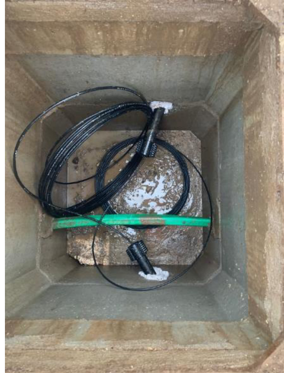
Abbildung 16: Im Verteilschacht wurden mithilfe einer Muffe eine Leitung aus dem Rohrverbund des vorgelagerten Breitbandnetzes (grüne Leitung) mit dem LWL zum Testfeldstandort und dem LWL zur Übergabestation gekoppelt (Foto: ZSW).
