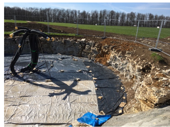
Abbildung 33: Betonage der Ausgleichsschicht Anfang April 2021 (Foto: ZSW)
