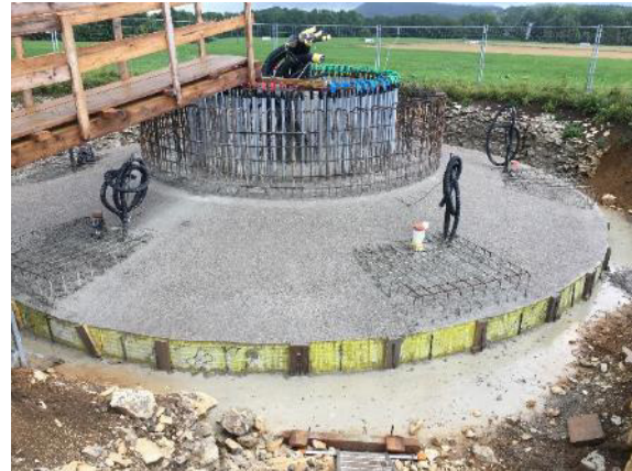
Abbildung 40: Im letzten Betonageschritt wurden die Sockel für die Zugangsschächte zur geotechnischen Instrumentierung betoniert.
