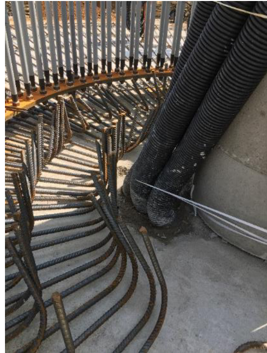
Abbildung 36: Am Zentralschacht konnten die Leerrohre nach oben geführt werden. Sie sind nach Errichtung der FWEA im Turmkeller der jeweiligen Anlage vorzufinden.
