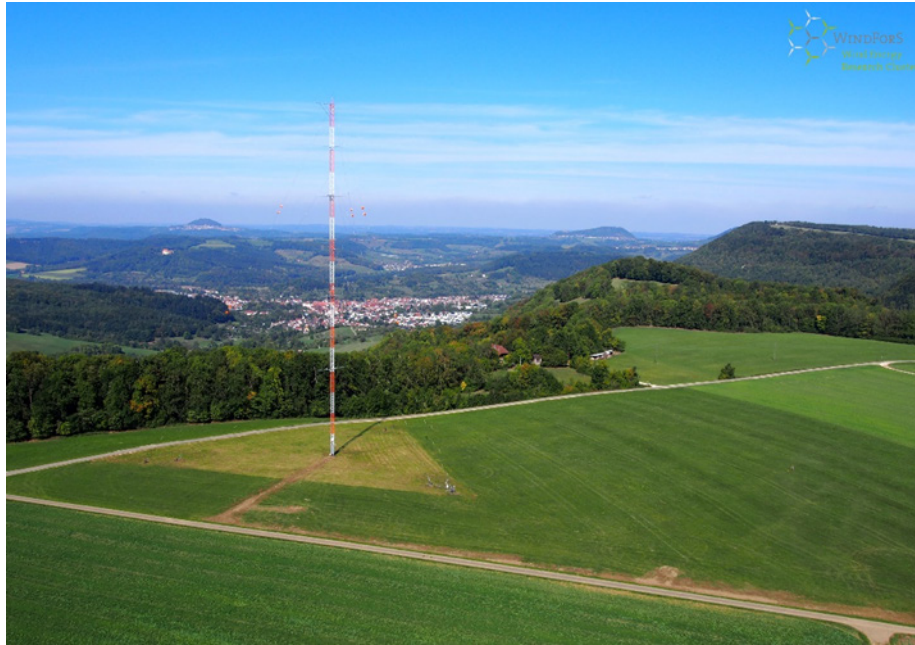
Abbildung 23: Unterhalb des im November 2017 errichteten Windmessmast WMM-NW(North-West) ist deutlich jenes einbeschriebene Dreiecke zu erkennen, welches von den Abspannfundamenten aufgespannt wird und unter dem vom 1. April bis 31. August eines jeden Jahres aus Artenschutzgründen nicht gemäht werden darf. (Quelle: WindForS)
