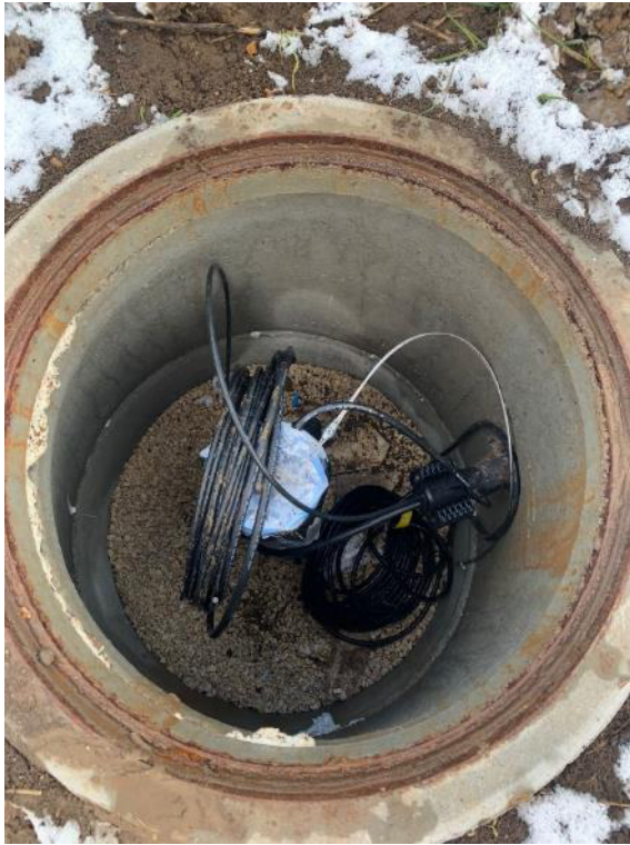
Abbildung 18: Anbindung der seismischen Messstationen an die testfeldinterne Verkabelung (Foto: ZSW)
