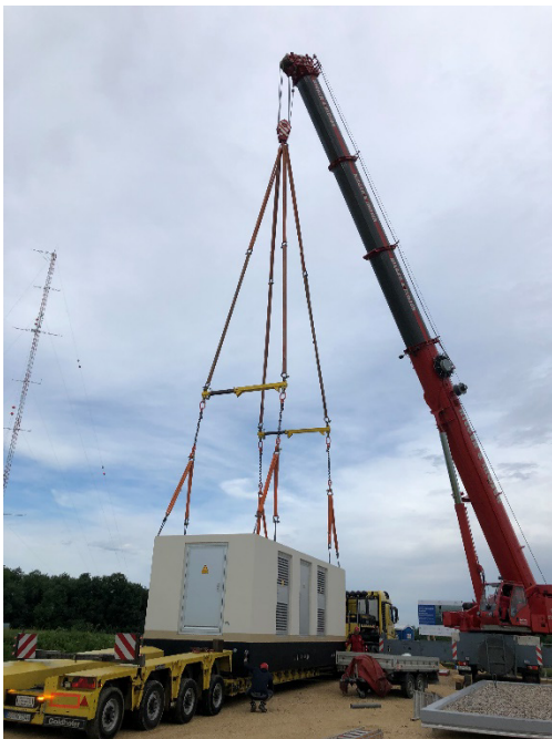
Abbildung 12: Errichtung der nördlichen Trafostation auf die vorbereitete und verdichtete Fläche am Rand der Kranstellfläche (oben, rechts) (Fotos: ZSW).
