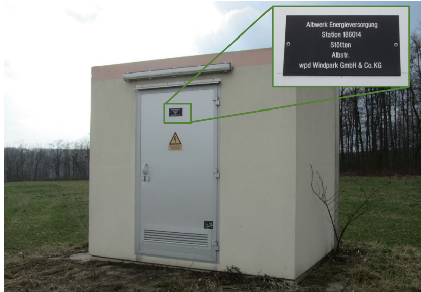
Abbildung 7: Übergabestation der wpd Windpark GmbH & Co. KG am Rand der Stöttener Steige zwischen der Stadt Geislingen und dem Ortsteil Stötten (Foto: ZSW).
