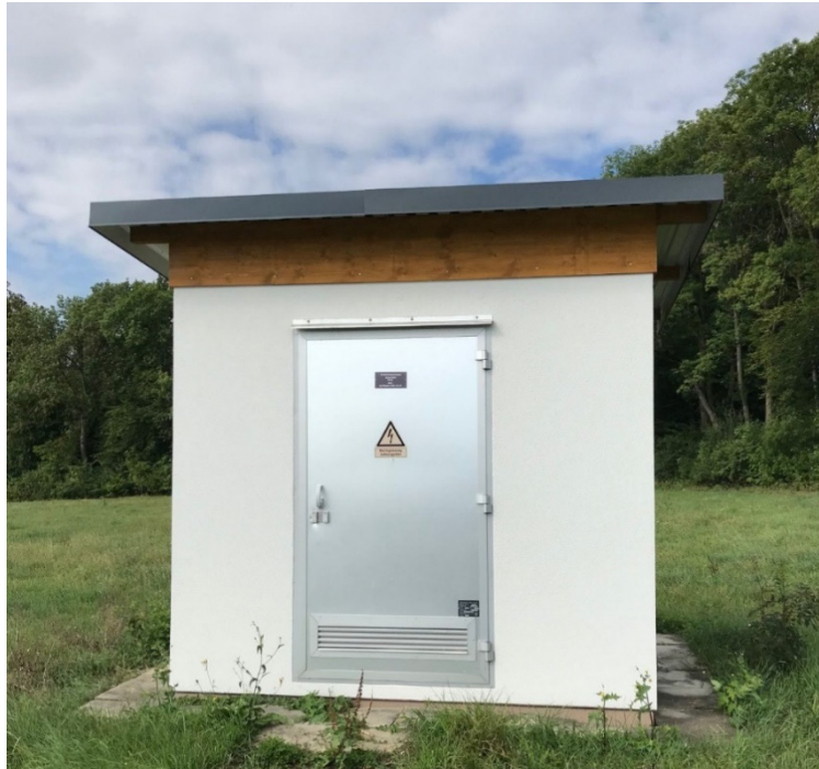
Abbildung 8: Technisch überholte Übergabestation mit neuem Dach, renovierter Fassade und ertüchtigter Heizung und Lüftung (Foto: ZSW).
