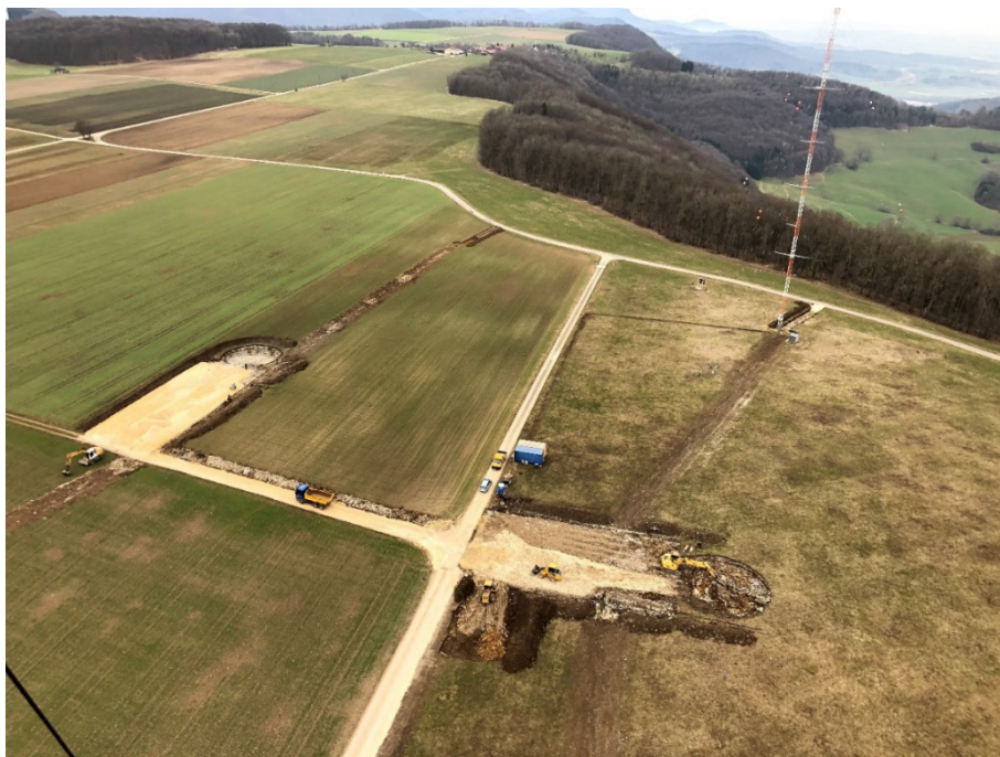
Abbildung 29: Aufnahme vom nordöstlichen Windmessmast (März 2021): zu sehen sind die bereits wieder aufgefüllten Gräben der testfeldinternen Verkabelung, die Wegverbreiterung (unterer Bildrand, bzw. linke untere Hälfte), die Kranstellflächen, die Fundamentgrube des südlichen Fundaments (links) sowie der Aushub des nördlichen Fundaments (rechts). (Foto: ZSW).
