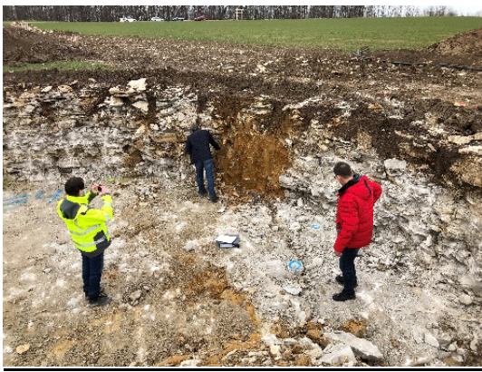
Abbildung 30: Begehung der freigelegten Fundamentsohle durch den Prüfstatiker (Ing.-Bürogemeinschaft Nellingen), den Geologen (Smoltczyk & Partner GmbH) und den Gesamtbauleiter (S&G Engineering) (Foto: ZSW)
