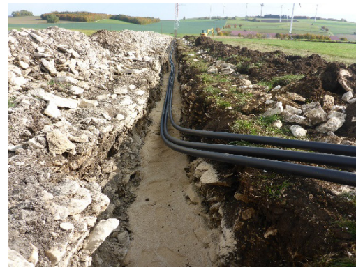
Abbildung 26: Kabelverlegearbeiten im Testfeldgebiet (Foto: ZSW).
