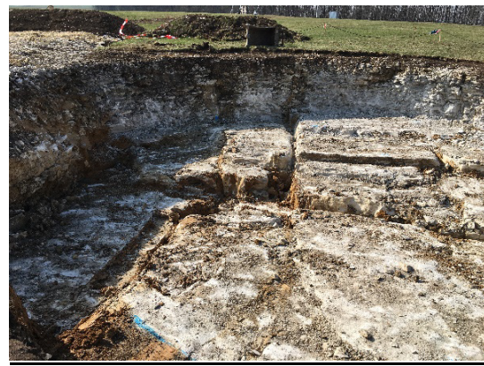
Abbildung 31: Fundamentsohle mit freigelegten Klüften vor der Aufbringung der Ausgleichsschicht (Beton) (Foto: ZSW)
