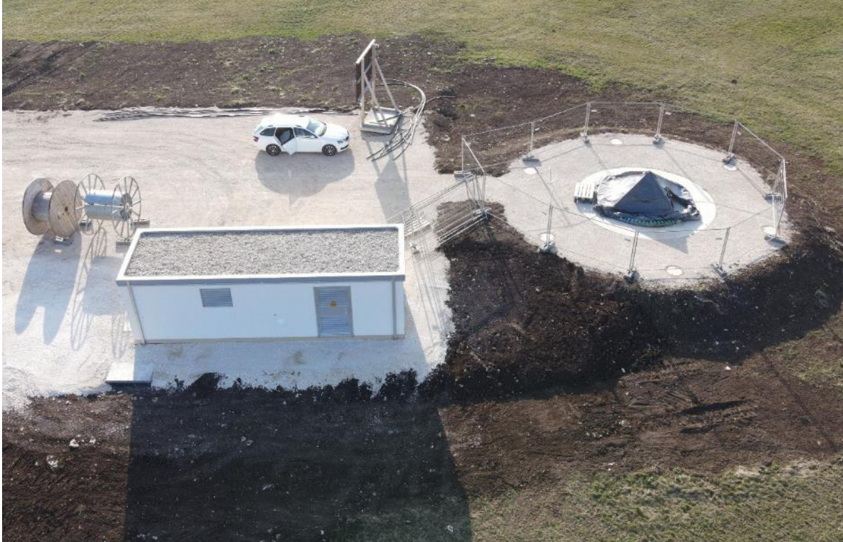
Abbildung 42: Blick von oben auf einen Teil der fertiggestellten Kranstellfläche, auf die Trafostation sowie auf den verfüllten und angeböschten Außenbereich um das Fundament der nördlichen FWEA. Innerhalb des Bauzauns sind die sechs Schachtdeckel zu erkennen, unter dem Planendach befindet sich geschützt der Ankerkorb samt Zentralschacht und Leerrohren.
