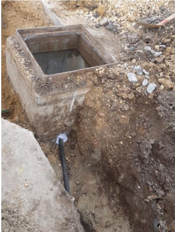
Abbildung 15: Auftrennung und Verlegung der bisherigen LWL-Leitung (im Besitz des ZSW) zwischen der Bestandsanlage und der Übergabestation in den Verteilschacht (Foto: ZSW)
