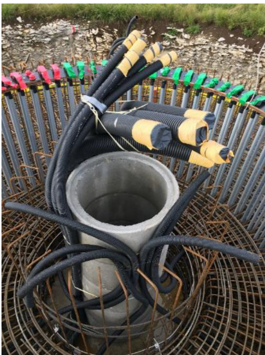
Abbildung 37: Der Zentralschacht und der Ankerkorb wurden gemäß Bewehrungsplan eingeflochten
