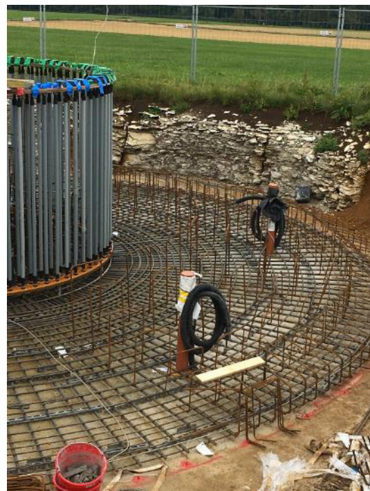
Abbildung 38: Die Fundamentbewehrung wurde ringsum eingebracht und die Zugänge zur geotechnischen Instrumentierung (im Bundesvorhaben verortet) durch die Bewehrung geführt
