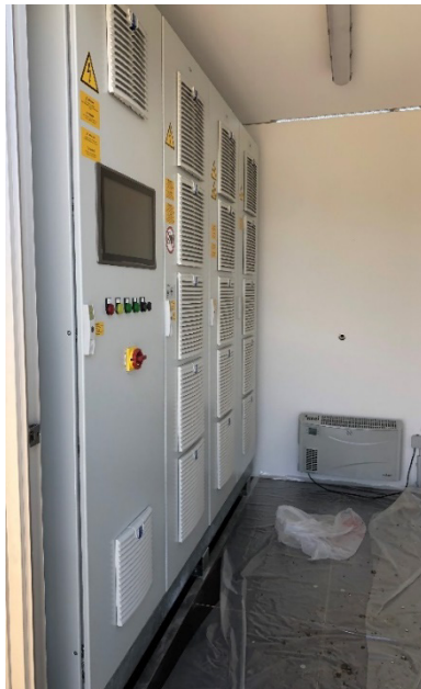
Abbildung 13: Umrichterschrank für die FWEA der Fa. Freqcon GmbH (Foto: ZSW).
