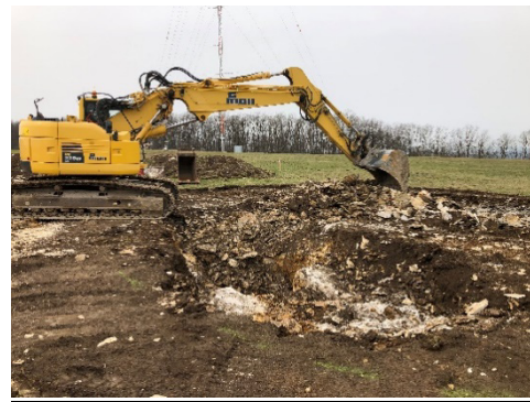
Abbildung 28: Aushub der nördlichen Fundamentgrube (Foto: ZSW).
