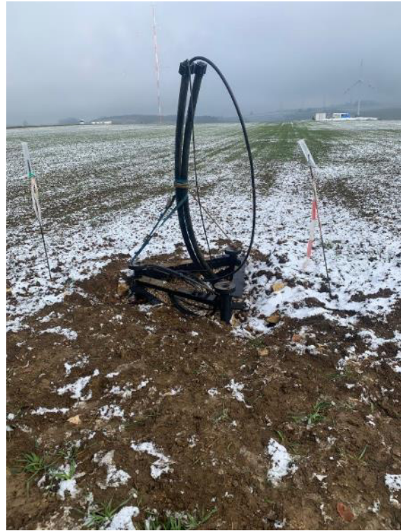
Abbildung 19: Anbindung der beiden südlichen Windmessmasten mit Erdleitungen und LWL, deren Errichtung in Q1 und Q2 2022 vorgesehen sind (Foto: ZSW)
