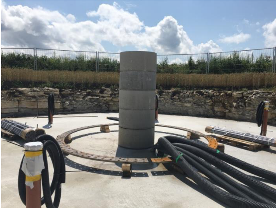
Abbildung 34: Zentralschacht auf der Sauberkeitsschicht für den späteren Zugang zur Fundamentsohle
