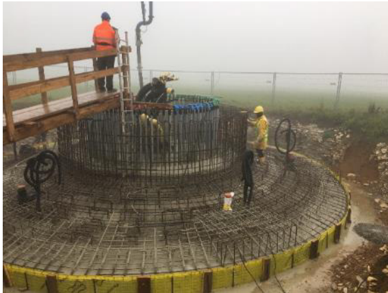
Abbildung 39: Die fertige Bewehrung wurde im Nachgang geschalt und anschließend in mehreren Schritten betoniert.
