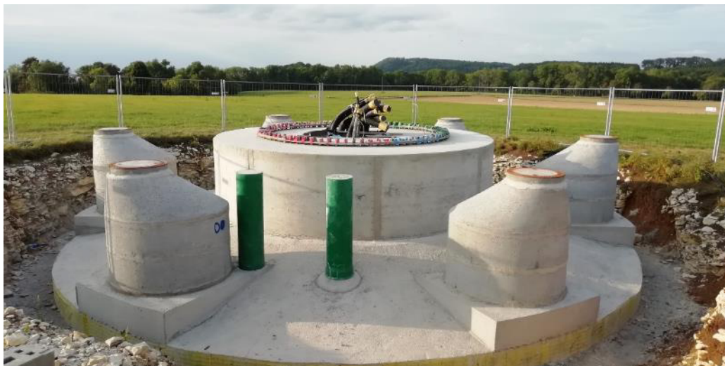
Abbildung 41: Fertiges Fundament der nördlichen FWEA mit den sechs im Umfang verteilte Zugangsschächten, dem Zentralschacht (nicht erkennbar), den Leerrohren und dem oberen Teil des Ankerkorbs. Die zwei grünen, mit Beton gefüllten Säulen sind für die Verankerung der Zugangstreppe zu den FWEA vorgesehen.
