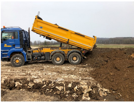
Abbildung 27: Separierung der unterschiedlichen Aushübe entsprechend der bodenkundlichen Genehmigung und Vorgaben (Foto: ZSW).
