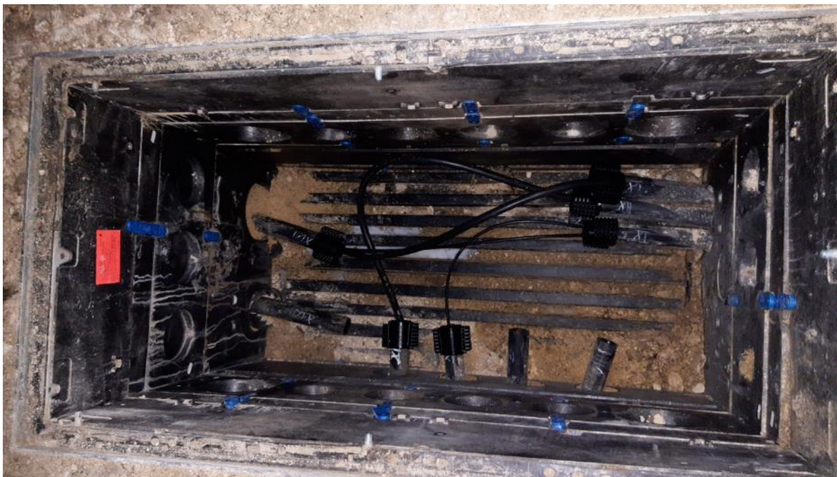
Abbildung 17: Exemplarischer Verteilschacht im Zuge der Baumaßnahme „Testfeldinterne Verkabelung“ mit Leerrohrenden, LWL und Stromleitungen (Foto: ZSW)
