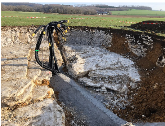
Abbildung 32: Einbringung von Leerrohren für den Netzanschluss und für die Sensorleitungen vor dem Aufbringen der Ausgleichsschicht (Foto: ZSW)
