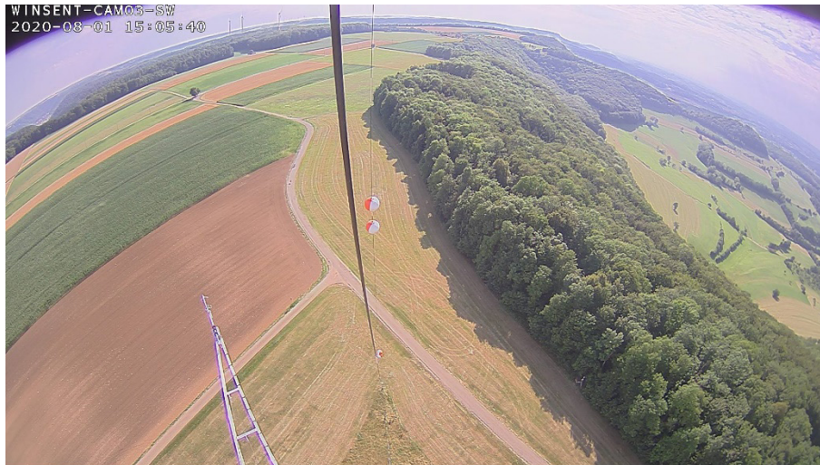
Abbildung 22: Aufnahme der nach Südwesten gerichteten Umfeldkamera an WMM-NW, Installationshöhe: 80m (Foto: ZSW).
