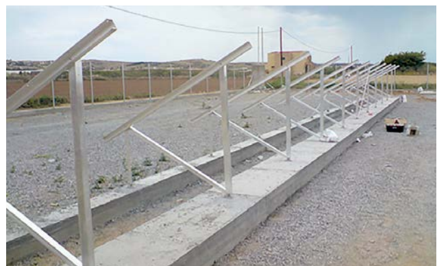
Abbildung 3.4: Beispiel Betonfundament (Anordnung längs oder quer)
