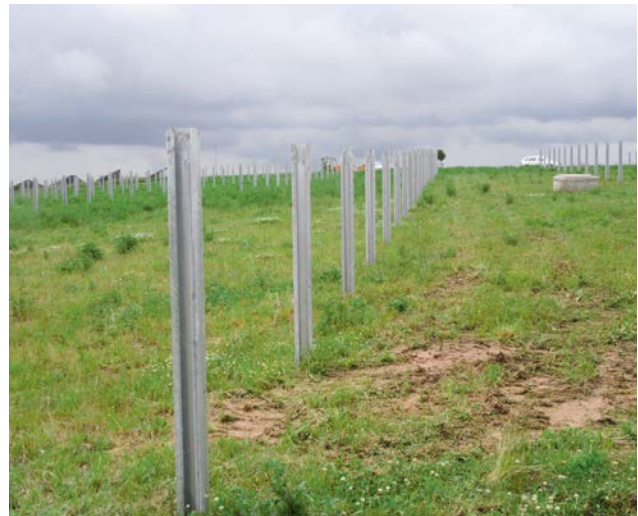
Abbildung 3.2: Beispiel Rammfundamente
