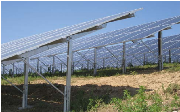
Abbildung 3.1: Beispiel einer Reihenaufstellung mit großen Montagegestellen
