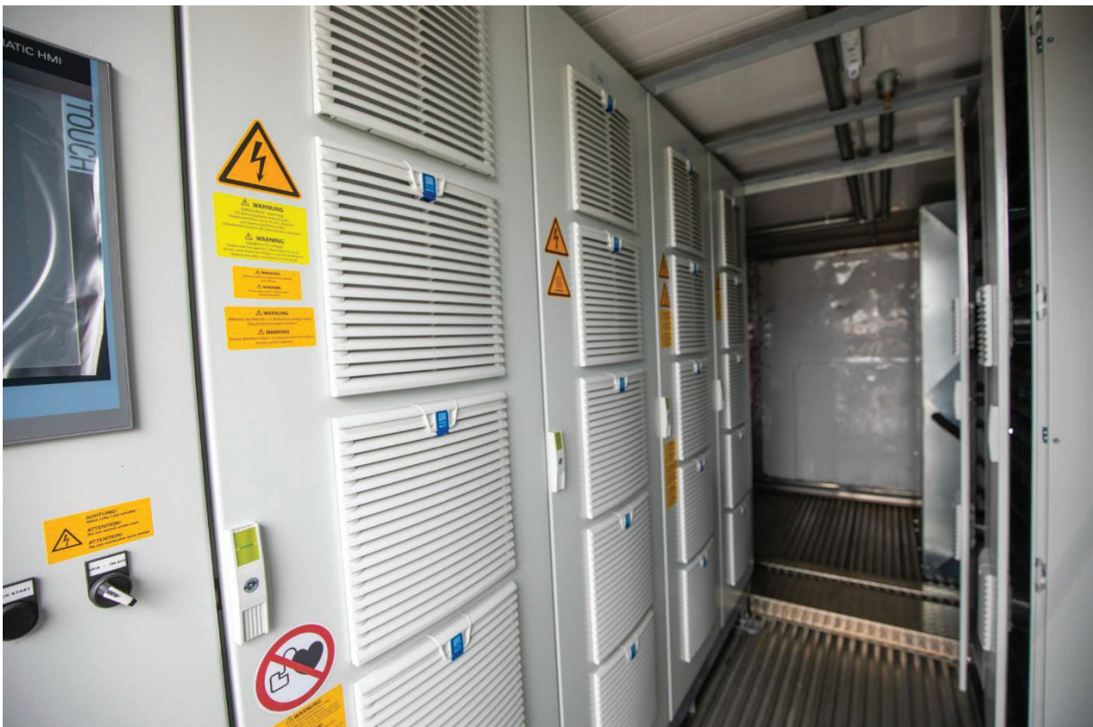
Abbildung 6: Schaltschränke und Leistungselektronik (links)
