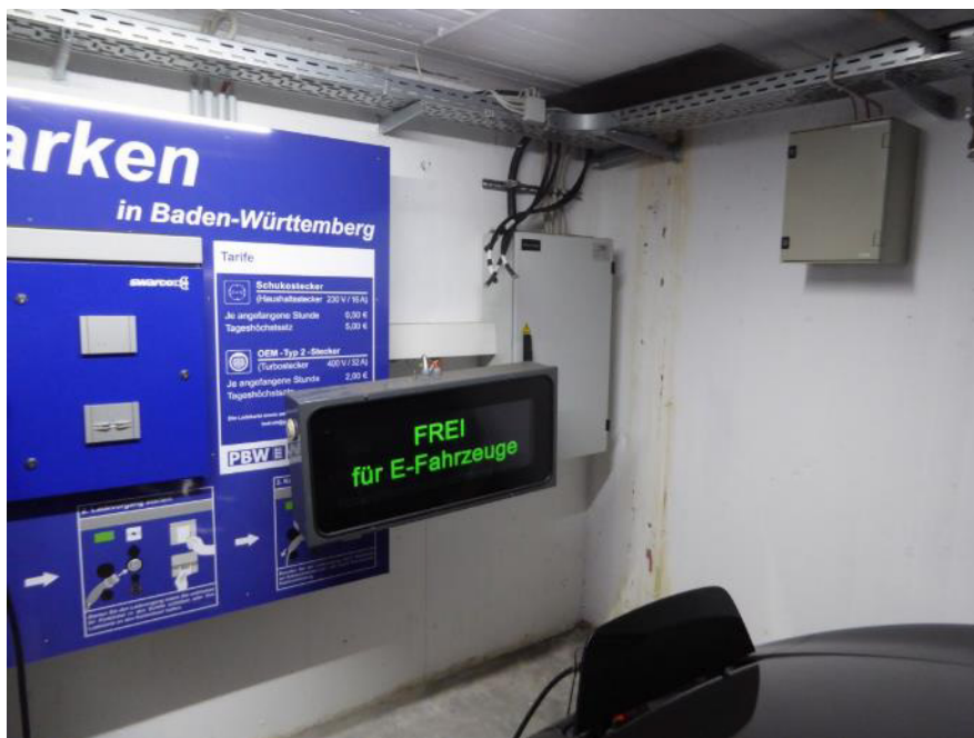
Abbildung 6: alter Unterverteiler für die Ladesäulen - Einbausituation
