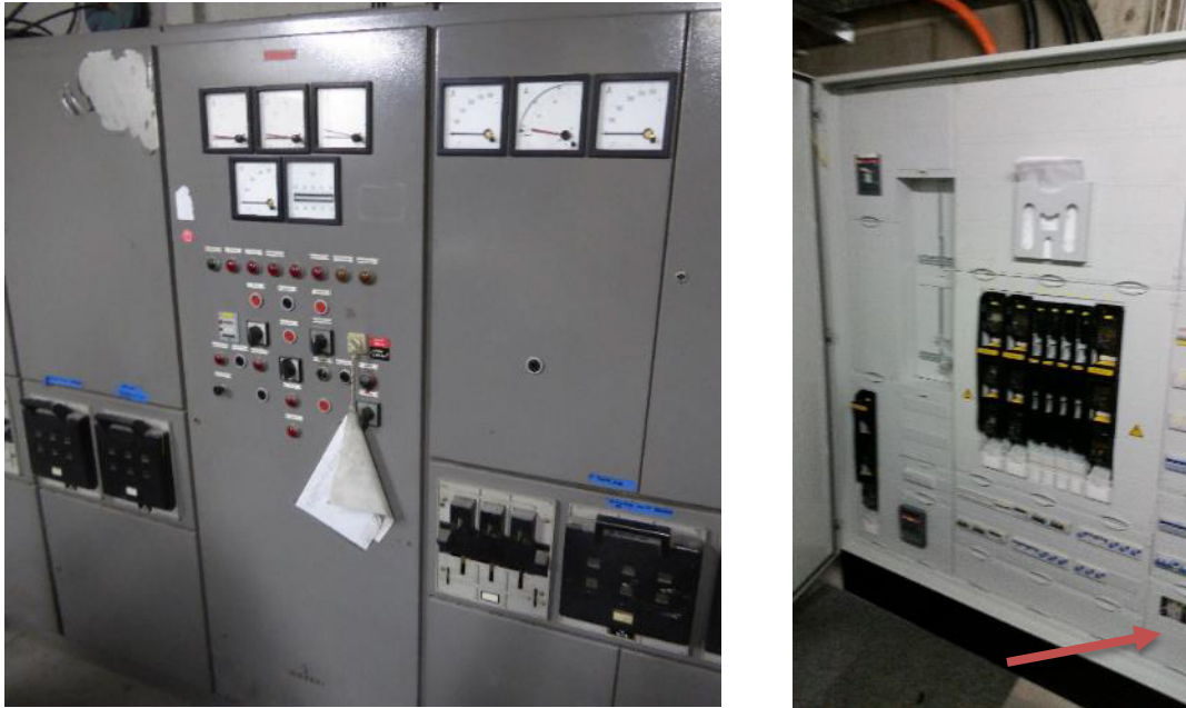
Abbildung 3: alter Hauptverteiler links und neuer Hauptverteiler rechts
