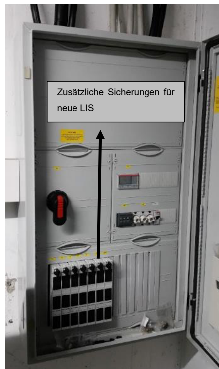
Abbildung 5: alter Unterverteiler nach der Installation der neuen Ladesäulen
