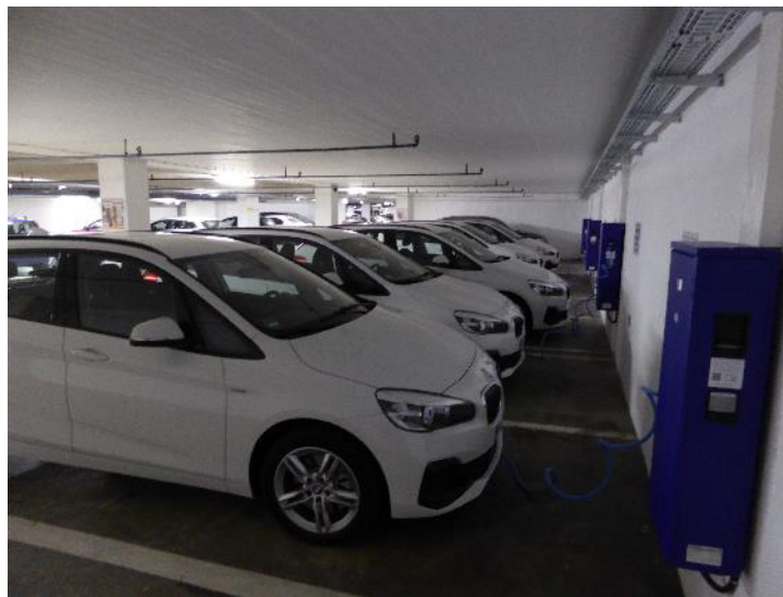
Abbildung 7: neue Ladestationen mit RPK-Fahrzeugen (noch ohne Folierung und Beleuchtung)
