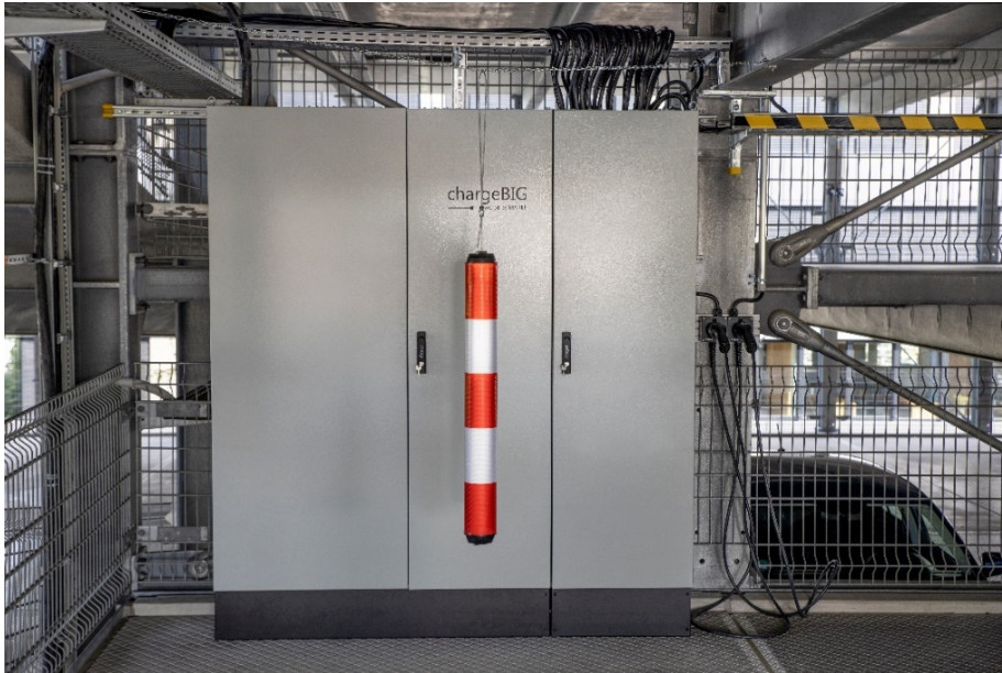
Abbildung 12: chargeBIG Ladeschrank bei der Trelleborg Sealing Solutions GmbH
