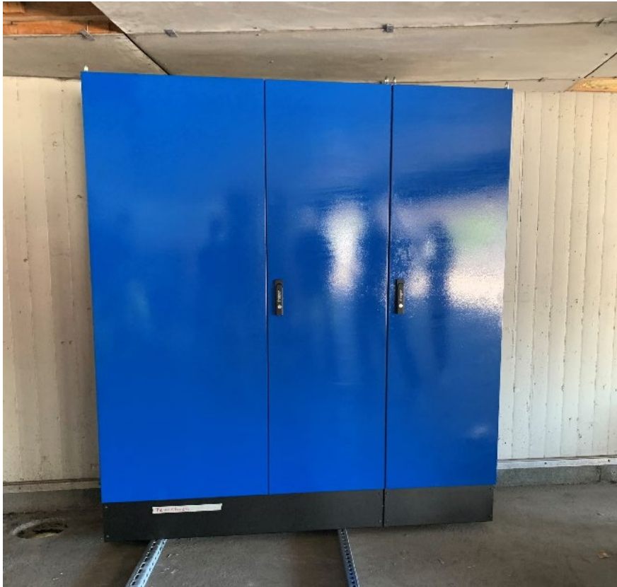
Abbildung 3: chargeBIG Ladeschrank am MAHLE Standort in Stuttgart Feuerbach
