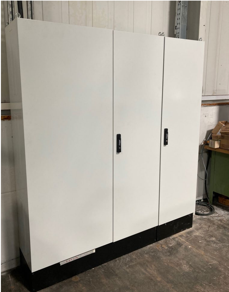
Abbildung 2: chargeBIG Ladeschrank im MAHLE Werk Lorch
