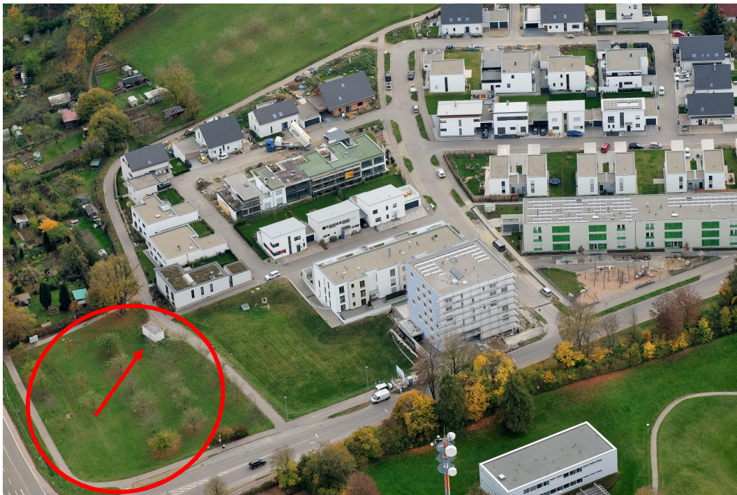
Abbildung 1: Luftaufnahme vom Neubaugebiet Hochvogelstraße mit EWS-Feld (roter Kreis) und Technikzentrale (roter Pfeil) Quelle: Privat
