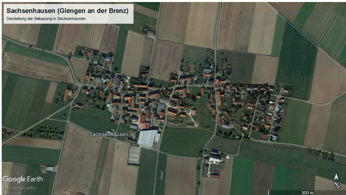
Abbildung 6: Darstellung der Bebauung in Sachsenhausen (Quelle GoogleEarth), innerhalb des Bildausschnitts befinden sich alle ausgewählten Pilotkunden. Die Biogasanlage, die das Nahwärmenetz versorgt, befindet sich in südlicher Richtung außerhalb des Bildausschnitts
