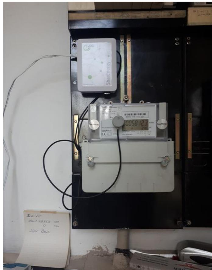
Abbildung 5 OLI Box kommuniziert mit einer modernen Messeinrichtung
