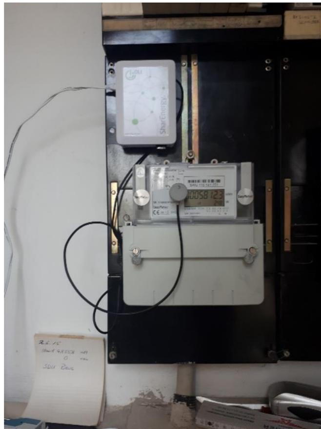
Abbildung 11 Beispielinstallation einer OLI Box an einer modernen Messeinrichtung
