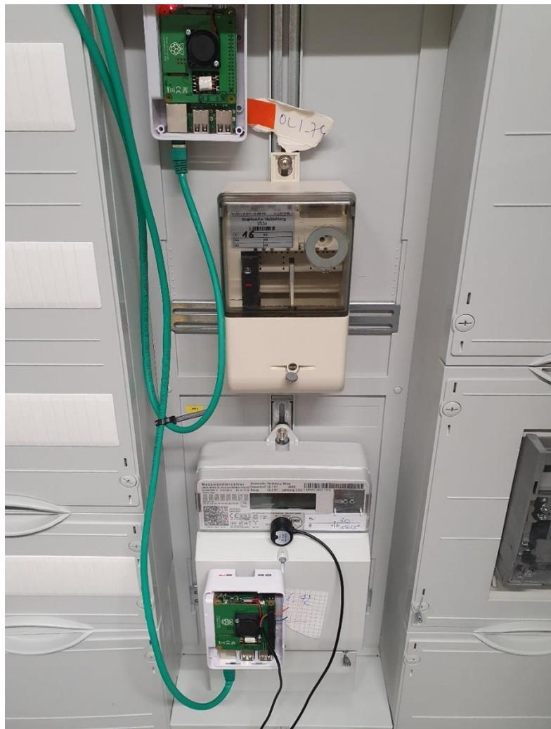
Abbildung 21 Zwei OLI Boxen mit PoE Modulen. Die untere OLI Box ist mit dem Hauptzähler verbunden.
