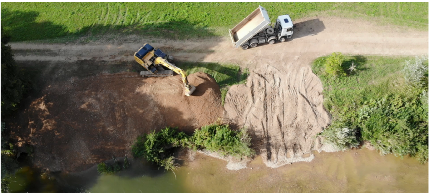
Einbau eines Kiesdepots am Neckar [RP Tübingen]
