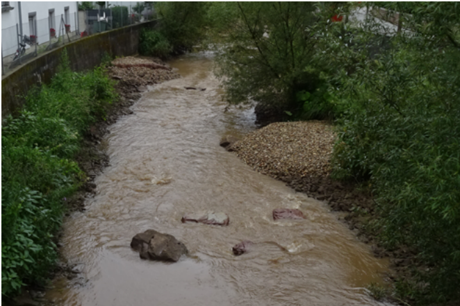
Herstellung von Kiesdepots an der Waldach (links) [Büro Heberle] und an der Elz (rechts) [RP Karlsruhe]
