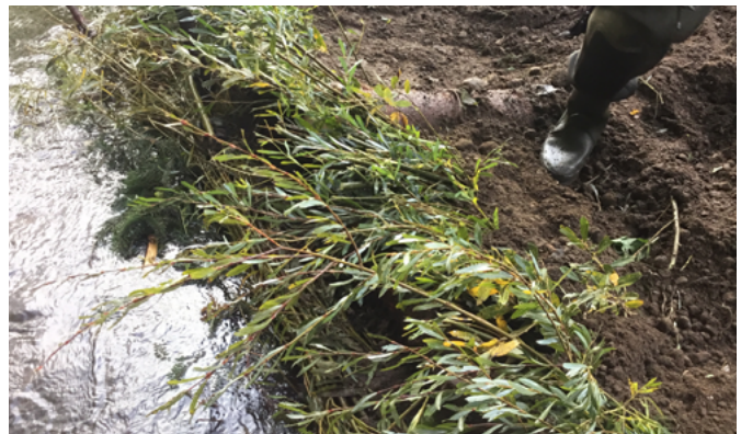
Ingenieurbioologische Sicherung mit Weiden [LRA Sigmaringen]
