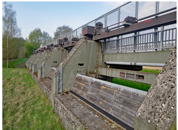
Abbildung 5.14: Gegengewichtsklappe der HWEA, HRB Hägenich [RP Karlsruhe]
