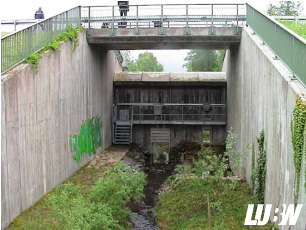
Abbildung 7.9: HRB Stadtseebach – Wartungssteg mit Treppe [LUBW]
