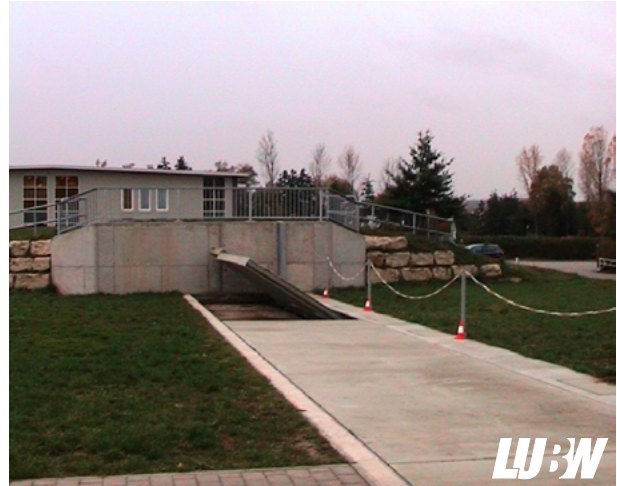
Abbildung 5.10: Verschluss mittels hochklappbarer Stahltafeln bei der Durchfahrt am Segelflugplatz [LUBW]
