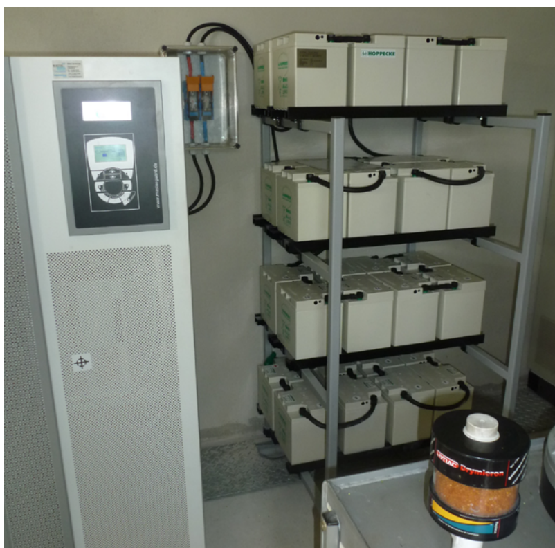
Abbildung 9.1: USV-Anlage mit Batterieeinheit [Bau+Plan]
