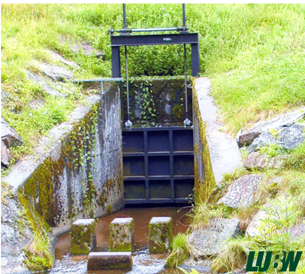
Abbildung 5.3: Ungesteuertes Gleitschütz, Fahrnau HRB im Kratten [LUBW]
