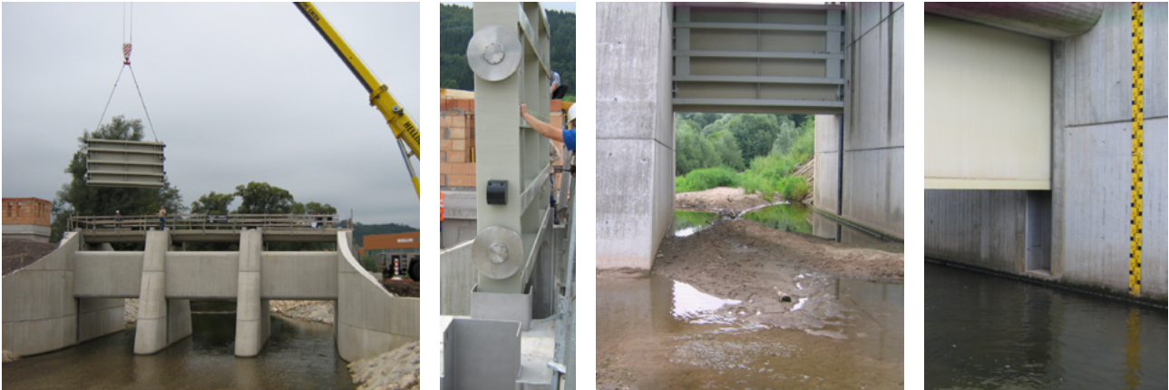
Abbildung 5.2: Dreiseitig dichtendes Rollschütz, HRB Lorch-Reichenhof, links beim Einbau, Mitte Ansicht vom Unterwasser, rechts Ansicht vom Oberwasser [WV Rems]
