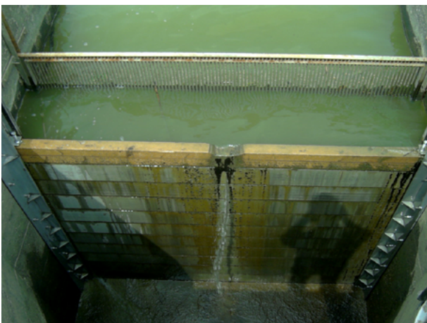
Abbildung 7.1: Dammbalkenverschluss [WBWF Stauwärterfortbildung]
