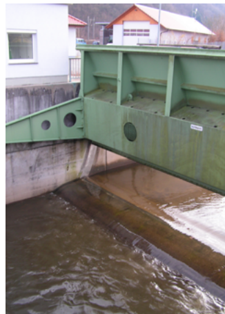
Abbildung 5.6: Drucksegment, HRB Mittleres Kinzigtal; links Ansicht oberwasserseitig; Mitte offene Stellung Ansicht Unterwasser, rechts Seitenansicht [WBWF Stauwärterfortbildung]
