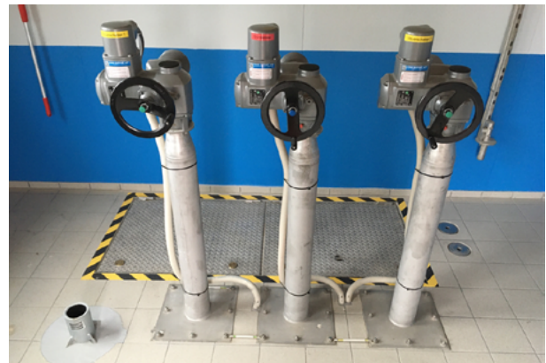
Abbildung 6.7: HRB Aichstrut – drei Stellantriebe [LRA Ostalbkreis]
