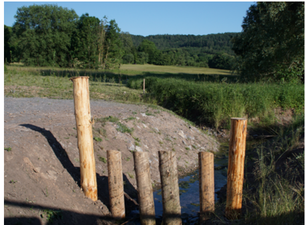
Abbildung 7.6: Einfacher Grobrechen, HRB Hasenbach 6 [LRA Ludwigsburg]
