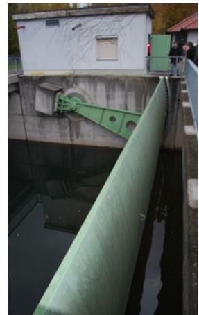
Abbildung 5.6: Drucksegment, HRB Mittleres Kinzigtal; links Ansicht oberwasserseitig; Mitte offene Stellung Ansicht Unterwasser, rechts Seitenansicht [WBWF Stauwärterfortbildung]
