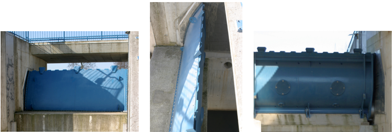
Abbildung 5.5: Fischbauchklappe, links Ansicht oberwasserseitig, Mitte Draufsicht, rechts Ansicht unterwasserseitig [WBWF Stauwärtterfortbildung]
