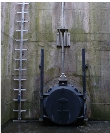
Abbildung 6.10: Absperrschieber mit Spindelantrieb [Bau+Plan]
