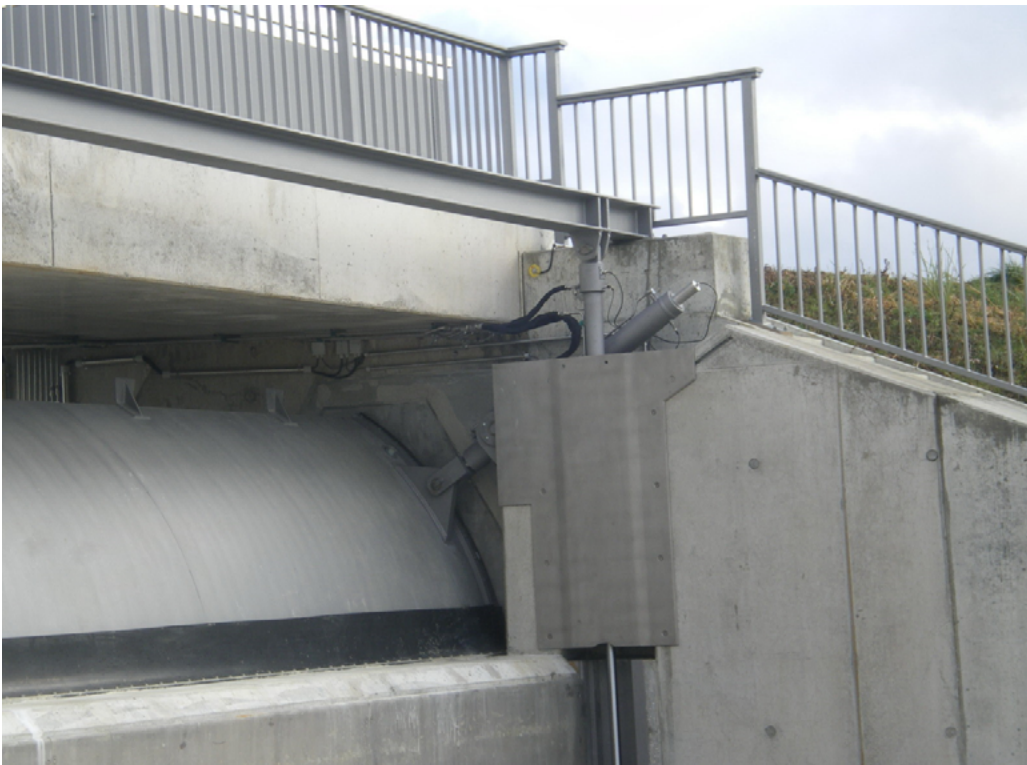
Abbildung 6.5: Hydraulikzylinder mit Klappe [WBWF Stauwärterfortbildung]
