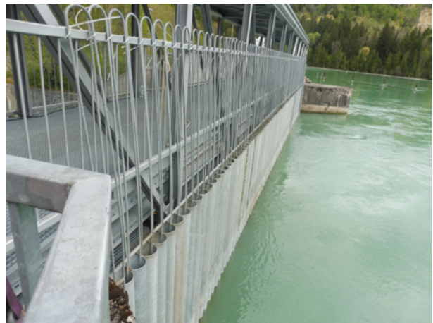
Abbildung 7.4: Rohrnadeln an einem Klappenwehr, wasserseitige Ansicht [Bau+Plan]
