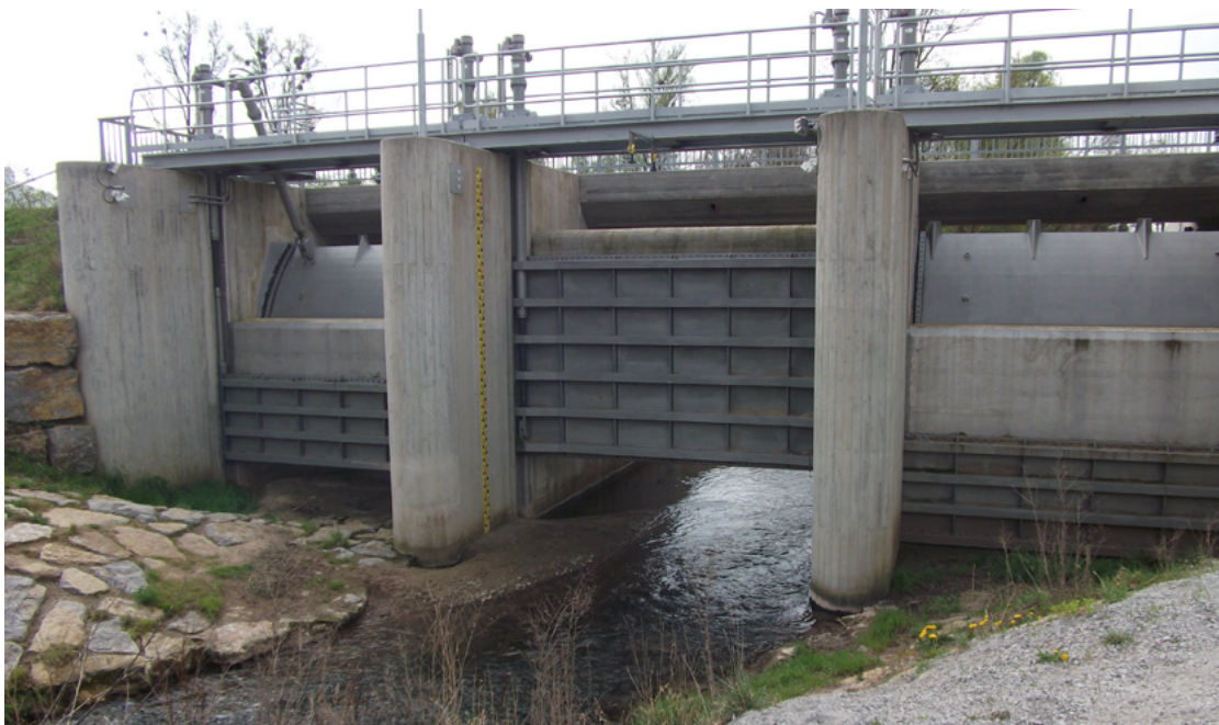
Abbildung 5.8: HRB Hoftal – Gleitschütz zur Betriebssteuerung und Klappe zur Hochwasserentlastung [LRA Ludwigsburg]
