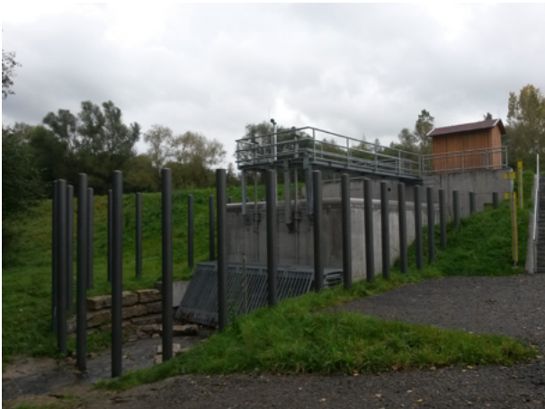
Abbildung 7.5: Grobrechen und räumlicher Rechen vor dem Betriebseinlass [Wald + Corbe]
