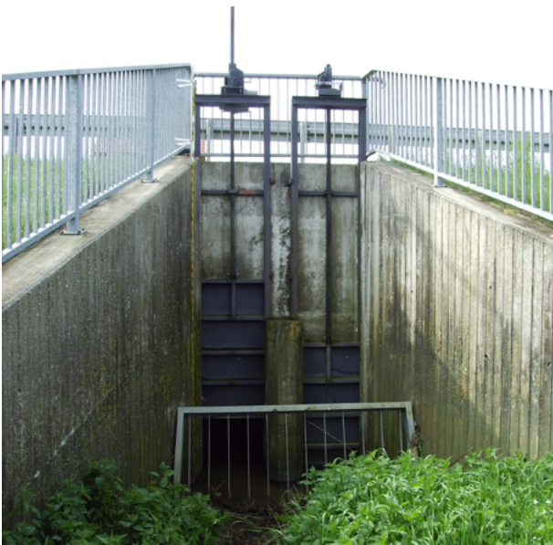
Abbildung 1.1: Schütz und Grobrechen, HRB Aalbach [WV Sechta-Eger]
