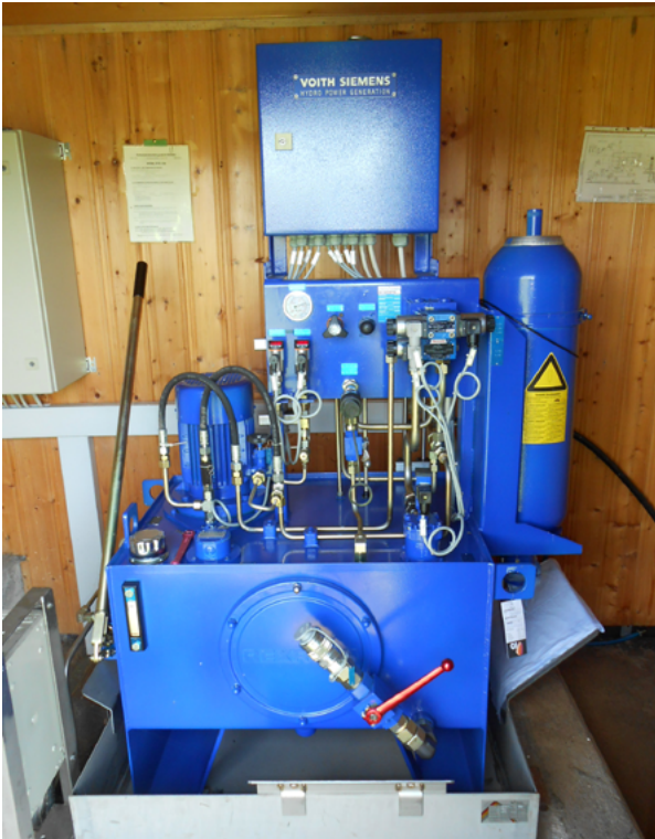
Abbildung 6.3: Elektrisch angetriebenes Hydraulikaggregat mit Druckspeicher, Ölauffangwanne und Handpumpe [WBWF Stauwärterfortbildung]
