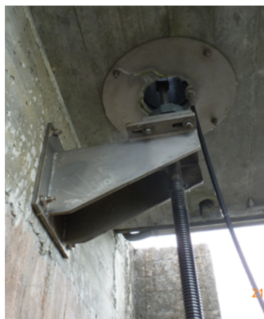
Abbildung 6.10: Absperrschieber mit Spindelantrieb [Bau+Plan]
