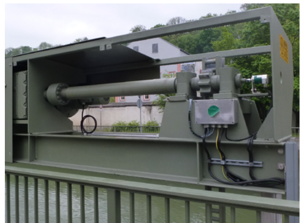
Abbildung 6.9: Triebstockantrieb [Bau+Plan]
