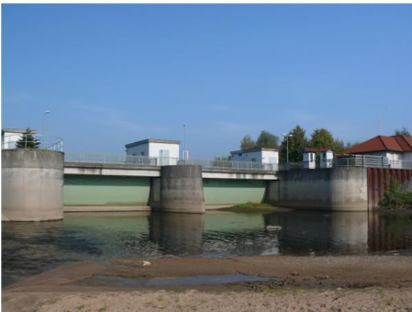
Abbildung 5.6: Drucksegment, HRB Mittleres Kinzigtal; links Ansicht oberwasserseitig; Mitte offene Stellung Ansicht Unterwasser, rechts Seitenansicht [WBWF Stauwärterfortbildung]
