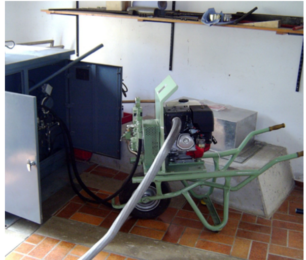
Abbildung 6.4: Mobiles Notfall-Hydraulikaggregat [WBWF Stauwärterfortbildung]
