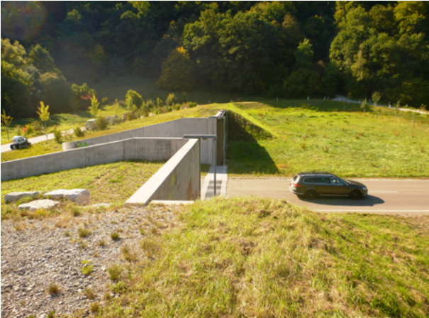
Abbildung 5.11: Damm und Rolltor [LRA Ludwigsburg]
