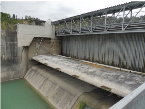
Abbildung 7.3: Rohrnadeln an einem Klappenwehr, luftseitige Ansicht [Bau+Plan]
