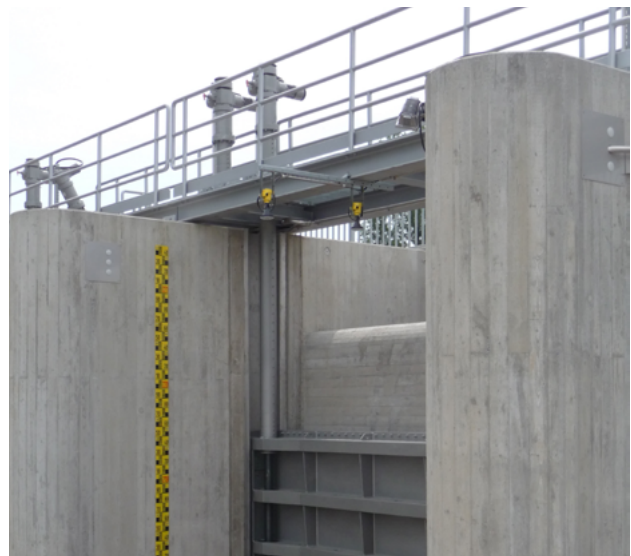
Abbildung 5.4: Gesteuertes Gleitschütz, HRB Großbottwar 4 [WBWF Stauwärterfortbildung]
