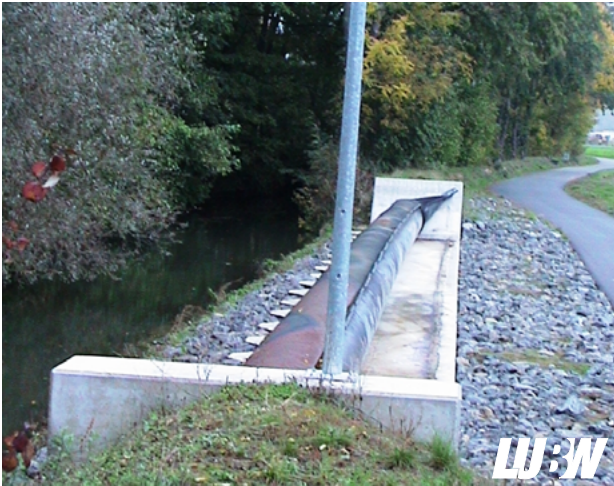
Abbildung 5.9: Schlauchwehr als Einlaufbauwerk zur Flutung des Segelflugplatzes [LUBW]
