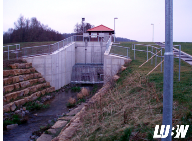
Abbildung 10.2: HRB Diehlheim-Baiertal – Rechen, Außenanlagen, Betriebsgebäude [LUBW]
