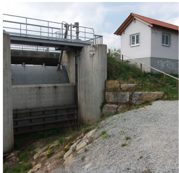
Abbildung 1.2: Fischbauchklappe und Schütz, HRB Hoftal [LRA Ludwigsburg]
