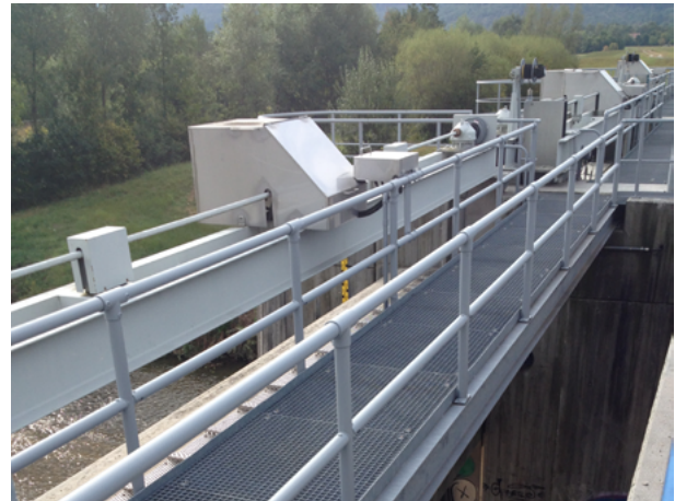
Abbildung 7.10: HRB Winterbach – Steg mit Geländer [Sieg]
