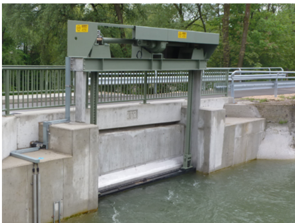
Abbildung 6.8: Gleitschütz mit beidseitigem Triebstock [Bau+Plan]
