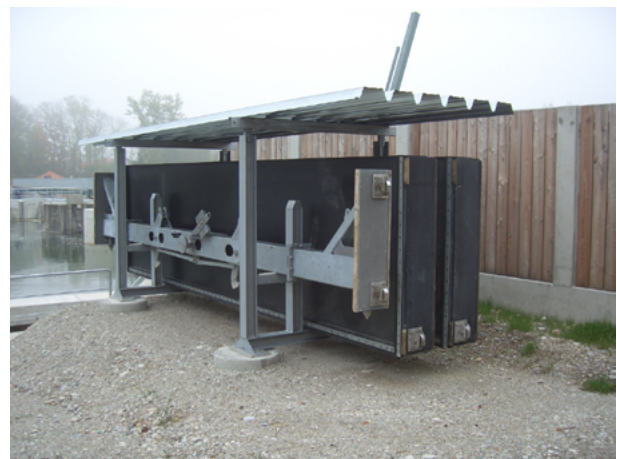
Abbildung 7.2: Lager mit Dammelementen und einem Zangenbalken [Bau+Plan]
