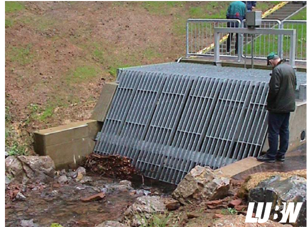
Abbildung 7.8: HRB Haager Tal – räumlicher Rechen [LUBW]
