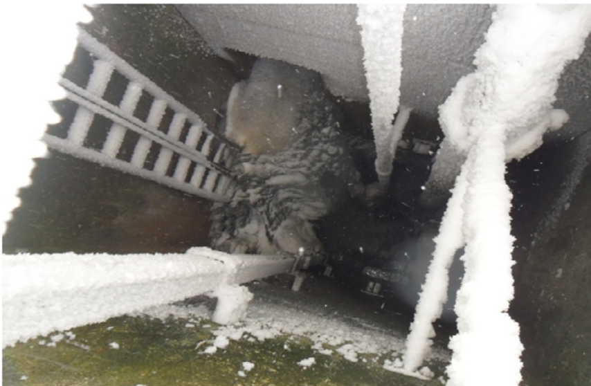
Abbildung 6.2: Eisbildung Schieberschacht [WBWF Stauwärterfortbildung]
