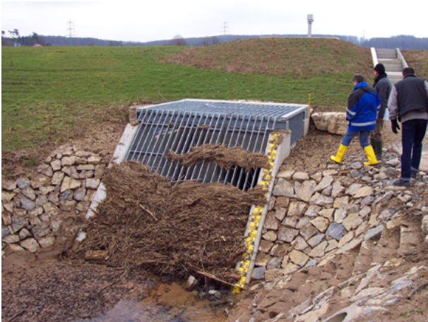
Abbildung 7.7: Rechen nach einem Einstau [LRA Neckar-Odenwald-Kreis]
