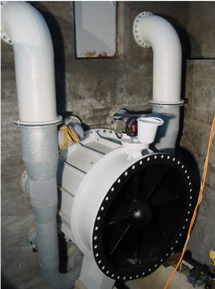
Abbildung 5.15: Kegelstrahlschieber – Naglod-Talsperre [RP Karlsruhe]
