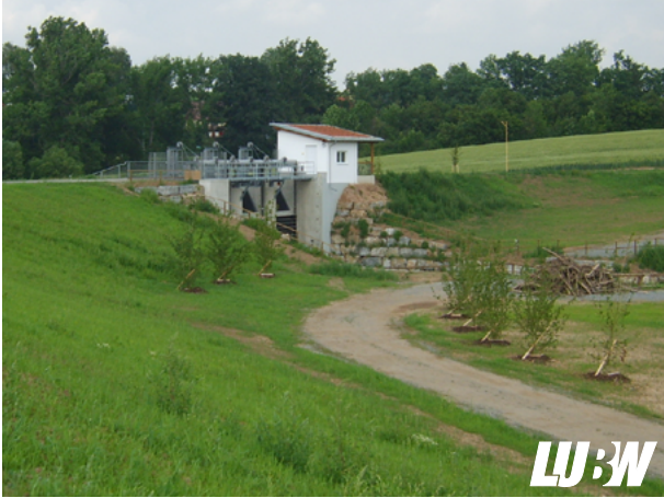
Abbildung 10.1: HRB Cappel Damm – Verschlussorgane, Betriebsgebäude [LUBW]
