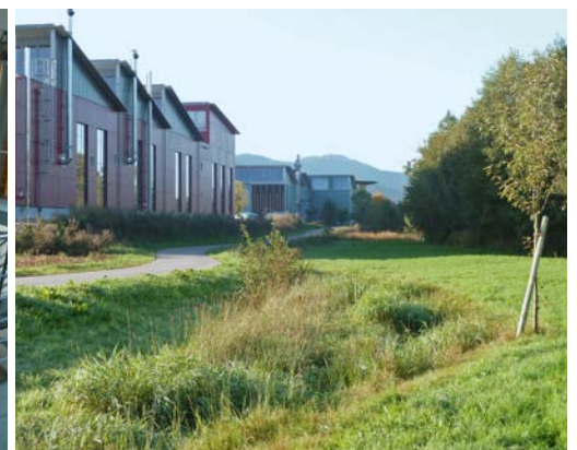
Für die Firmenerweiterung wurde ein Bach verlegt und renaturiert.
