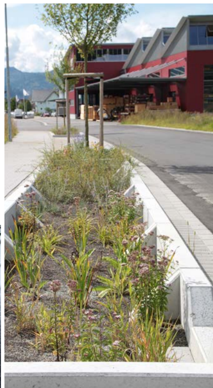
Rechts und unten: Bau einer Versickerungsanlage für beengte Verhältnisse: Verwendung eines durchlässigen Sickersubstrats, Bepflanzung mit heimischen Wildstauden. Gewerbegebiet Stollen, Gutach
