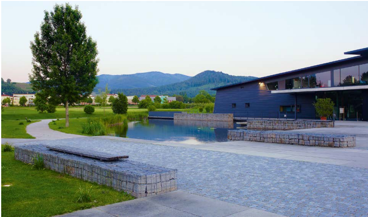
Bürgerhaus Denzlingen, von der „Natur“ zur Architektur: Wiese, Röhricht, Regenwasserteich, Holzdecks, Gabionen, Pflasterbeläge; Planung: Landschaftsarchitekten Faktorgruen, Freiburg und Cornelis, Denzlingen
