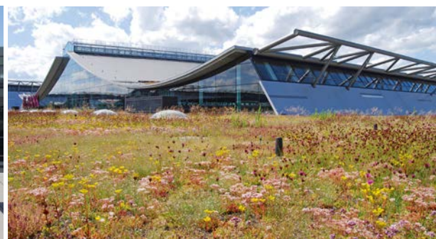
Neue Messe Stuttgart. Extensive Dachbegrünung, Adler + Olesch, Landschaftsarchitekten Nürnberg
