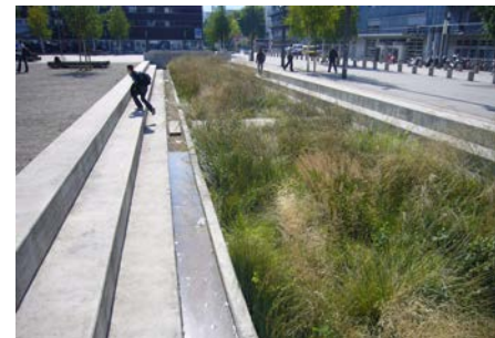
Turbinenplatz Zürich: Die Sickermulde ist gestalterisch in den Platz integriert; ADR Särl Architekten, Genf
