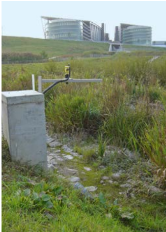
Das Oberflächenwasser der Neuen Messe Stuttgart versickert in einem Bodenfilterbecken und speist das Grundwasser.
