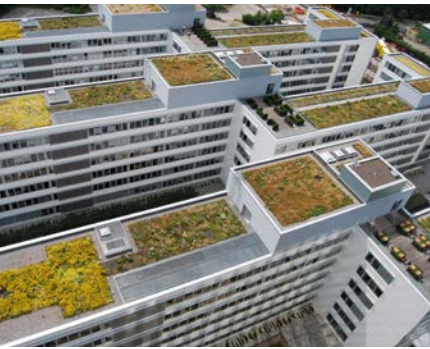
EnBW Verwaltung Stuttgart. Die extensive Dachbegrünung schafft kleine Naturinseln, die von den Dachterrassen aus auch für die Mitarbeiter erlebbar sind.
