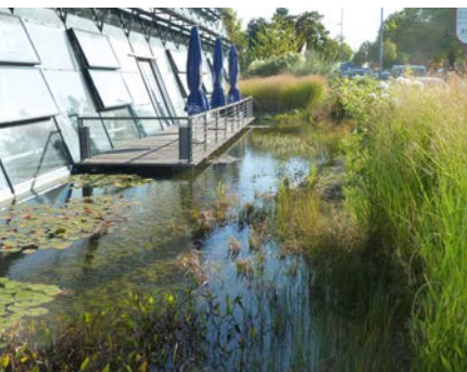
Bereits eingewachsener Regenwasserteich der Solar-Fabrik AG, Freiburg
