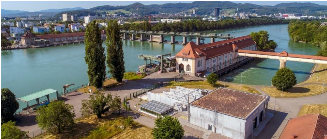
Abbildung 113: Wasserstoffproduktion am Wasserkraftwerk Whylen
