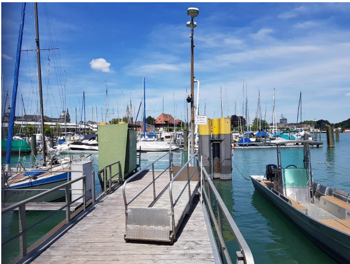
Abbildung 91: Anlegesteg und Tankstation im Konstanzer Stadthafen
