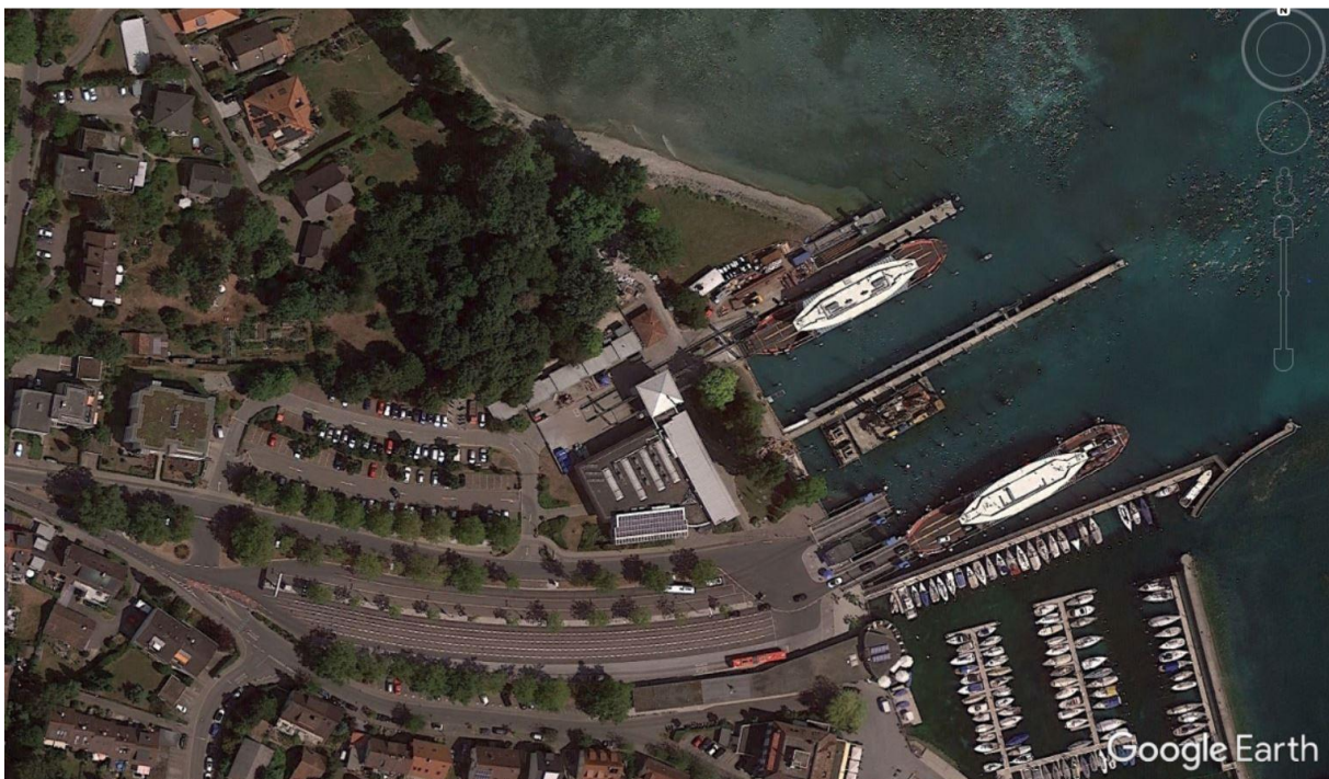
Abbildung 74: Fähranleger und Betriebsgebäude in Konstanz-Staad 119
