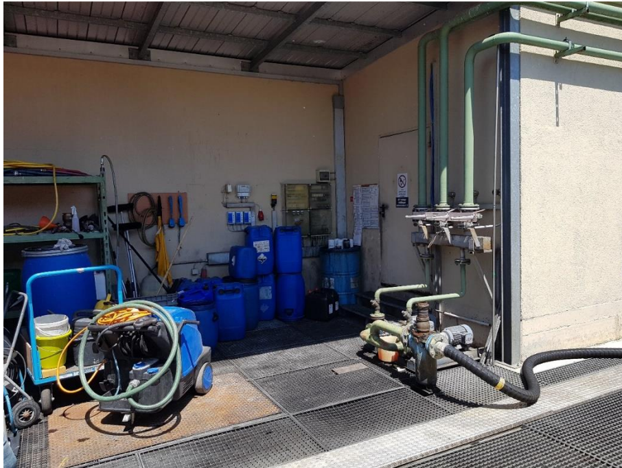
Abbildung 92: Übergabestation: LKW-Tankzug <-> Dieseltanks auf dem BSB-Gelände
