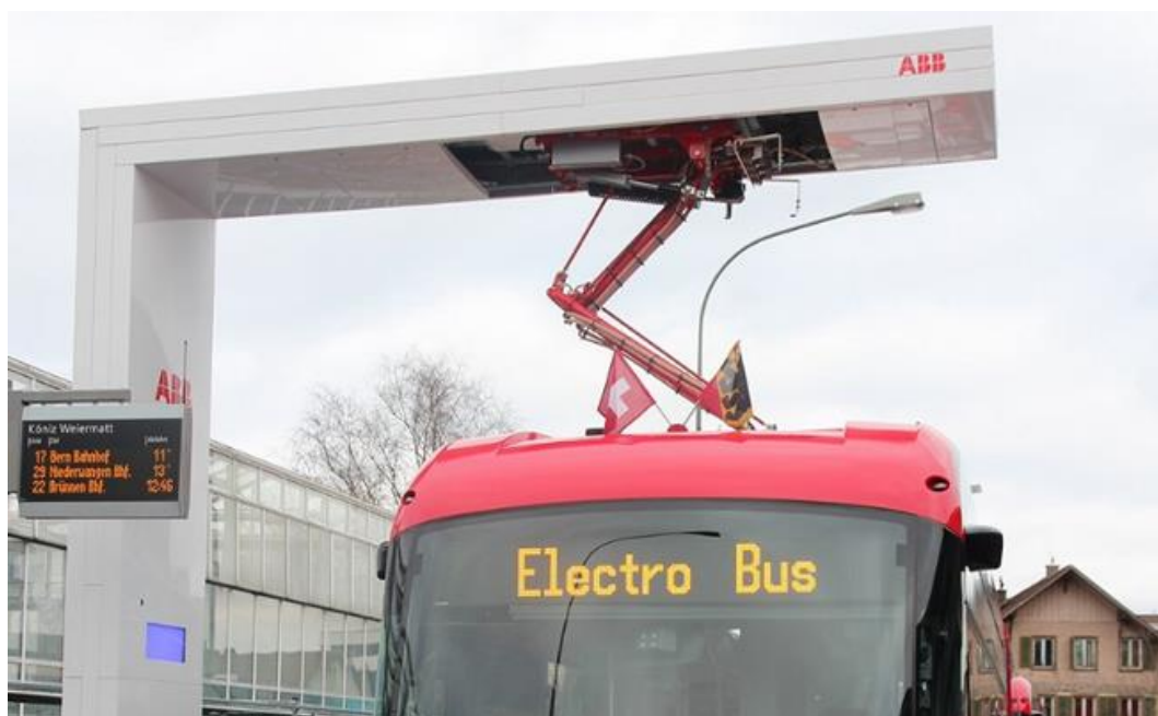
Abbildung 17: Pantographen als Opportunity Charger von der Firma ABB, die meist an der Endhaltestelle installiert werden 38
