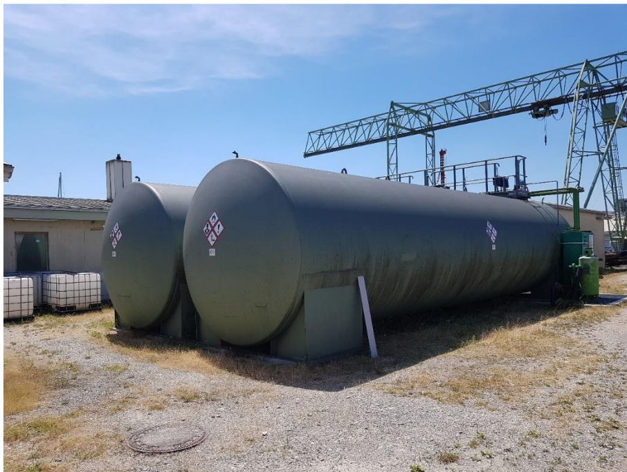
Abbildung 93: Doppelwandige Dieseltanks auf dem BSB-Betriebsgeländer im Konstanz-Stadthafen – 2x80.000l Dieseltanks – der 50.000l Tank ist auf dem Bild nicht sichtbar.
