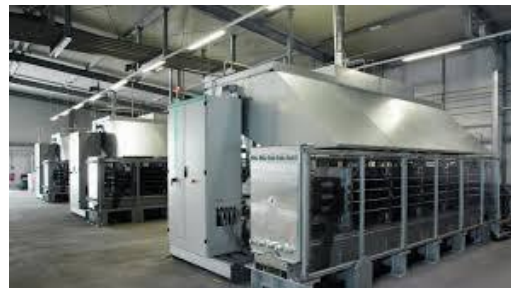
Abbildung 15 PEM Elektrolyse Energiepark Mainz
