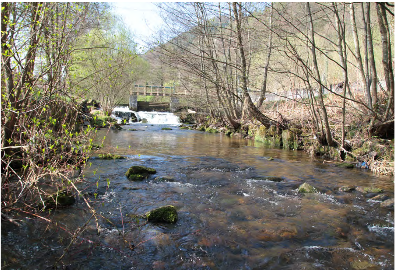
Abbildung 4-2: Ausreichende Durchgängigkeit auch an pessimalen Schnellen, Wasserkraftanlage Enz Höfen
