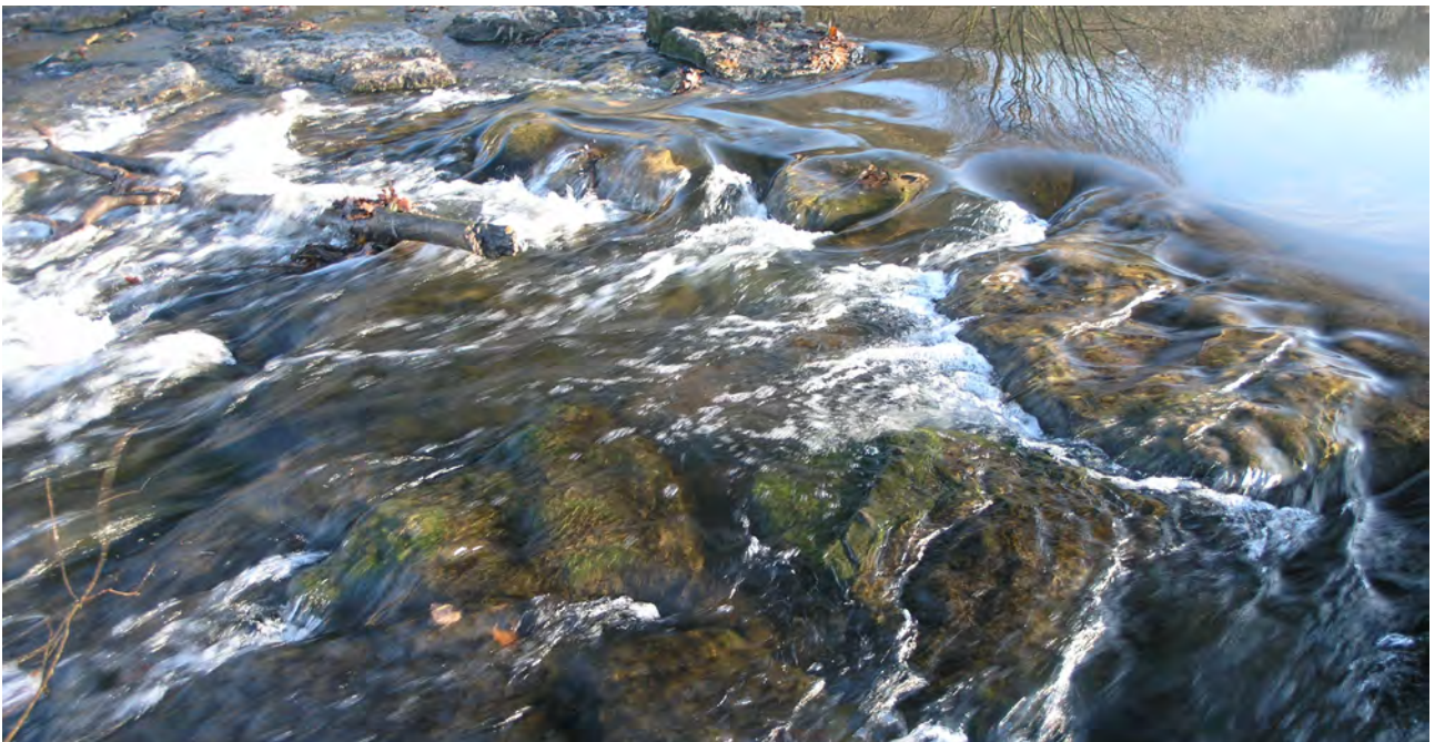
Abbildung 3-4: Strukturelle Anpassung zur Verbesserung der Durchgängigkeit in einem ausgebauten Gewässerabschnitt (hier Sicherung der Sohle für einen Düker)
