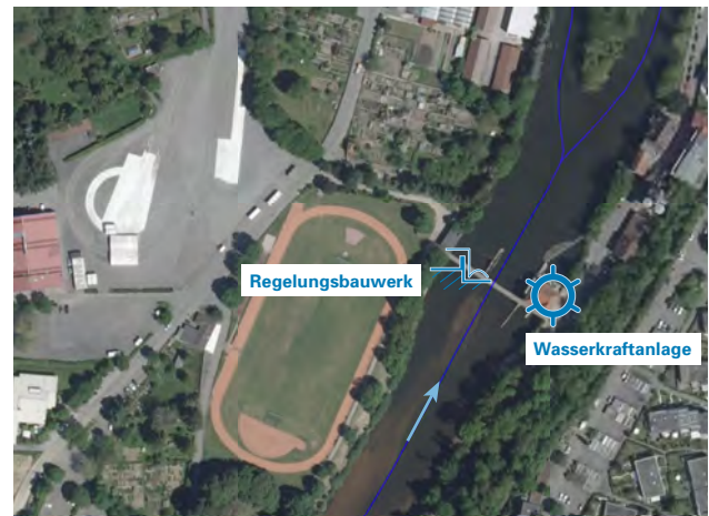
Abbildung 2-2: Flusskraftwerk Vaihingen Enz
