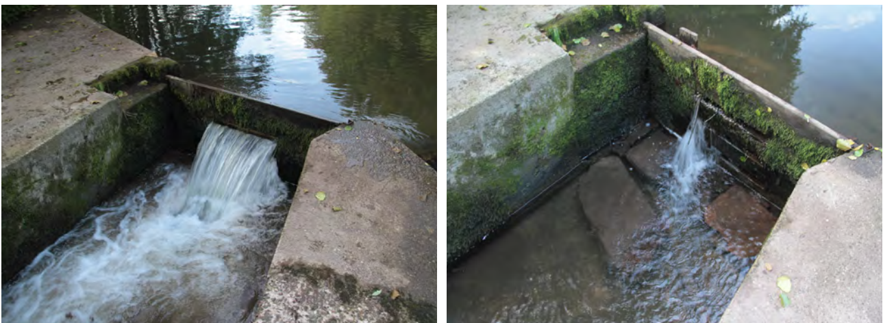
Abbildung 4-1: Falsch konstruiertes Dotationsbauwerk führt zu regelmäßigen Verstopfungen und erfordert einen hohen Unterhaltungsaufwand
