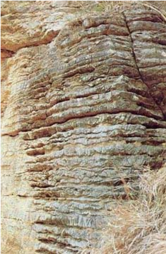
Abb. 41: Typische Schichtfolge im Trochitenkalk (mo 1) des Oberen Muschelkalks. Wechsellagerung von welligen Kalkbänken mit Mergellagen. - Aufschluss an Straße E Untergrombach [Lk Karlsruhe, lfd. Nr. 12]. Foto SCHÖTTLE
