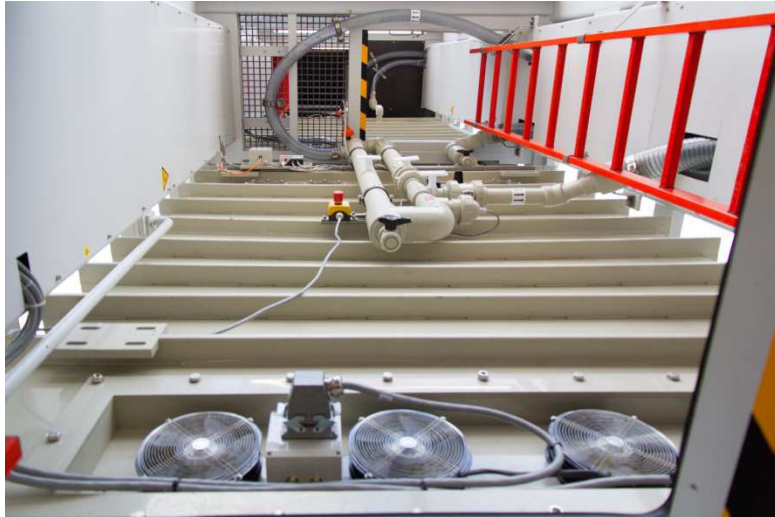
Abbildung 4.16 - 40' Container, Durchstiegslucken im Inneren
