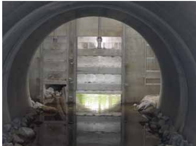
Abb. 7.3.4 und 7.3.5: Haupt u. Notauslassschieber (links im Bau), Lichteintrag über offenes Schachtbauwerk.
