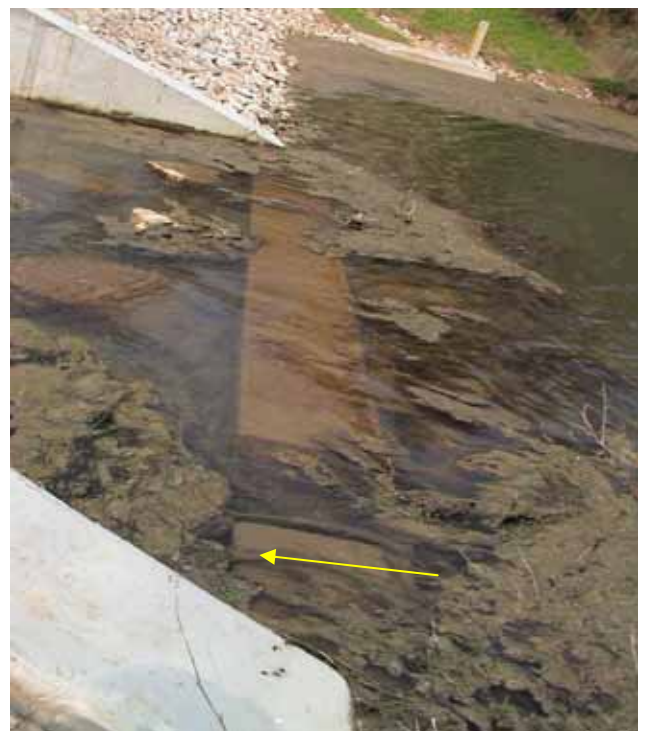
Abb. 6.3: HRB Seebach, Einlaufschwelle mit Aussparung.
