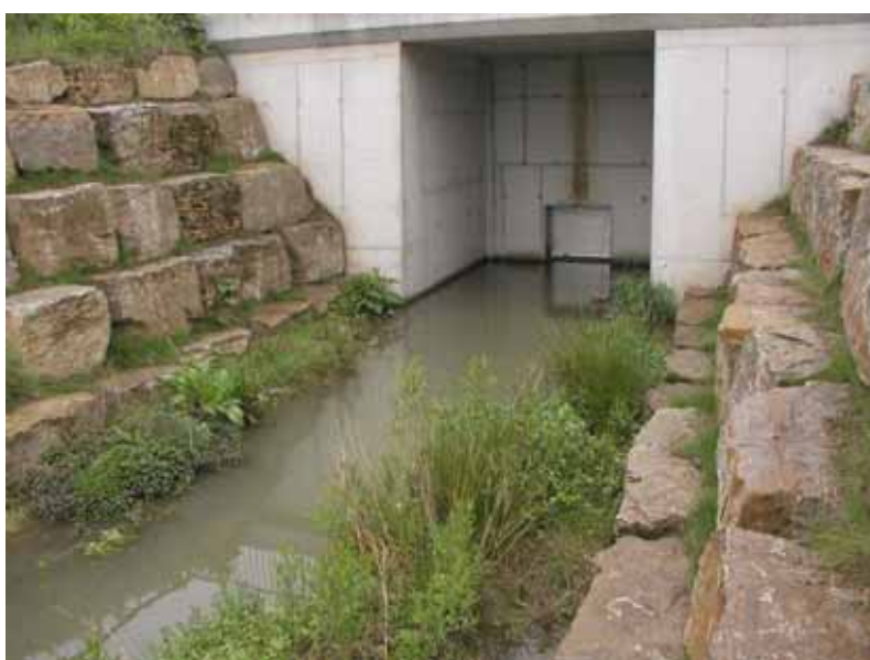
Abb. 7.4.5: Blick vom Unterwasser auf das Durchlassbauwerk.
