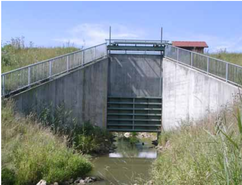
Abb. 7.9.4: Blick von Oberstrom.
