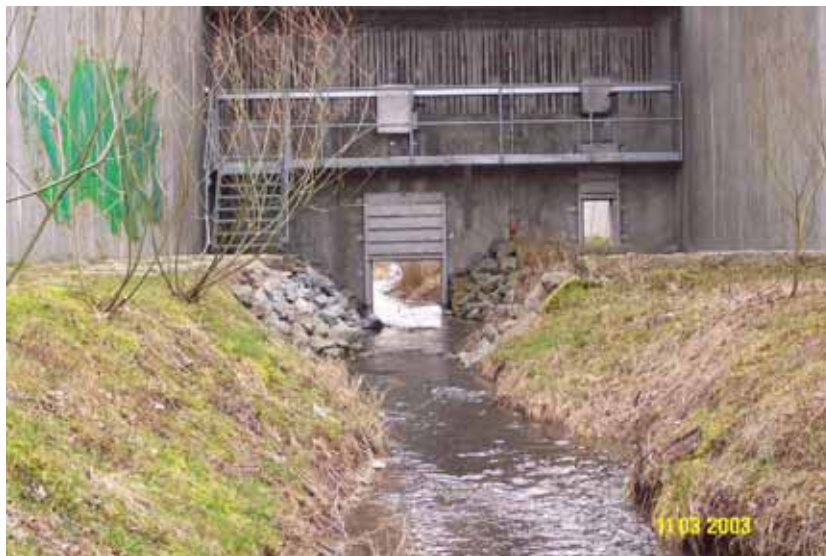
Abb. 7.1.4: Durchlassbauwerk von Unterwasser.
