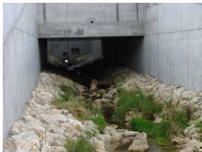
Abb. 5.12: Offene und geschlossene Abschnitte HRB Tonnenberg, Schenkenbach.
