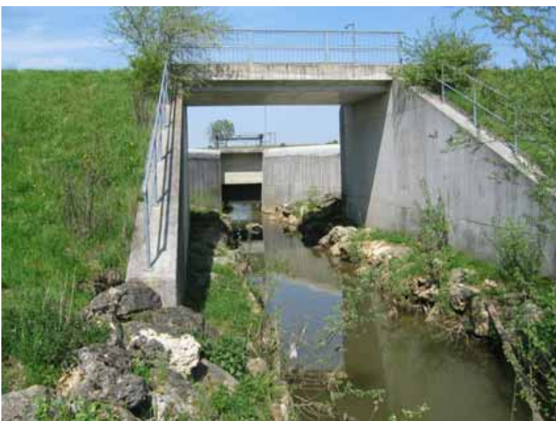
Abb. 7.8.4 bis 7.8.5: Durchlassbauwerk mit HWEA.
