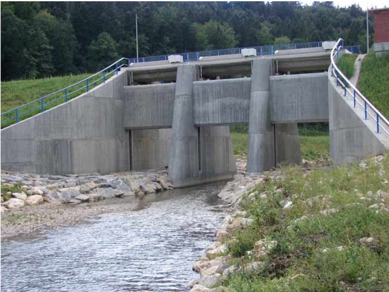
Abb. 7.14.3: Oberstrom HRB Nr.1 Reichenhof.
