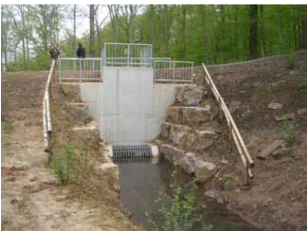
Abb. 7.17.7: Durchlassbauwerk des Umgebungsgewässers Köpferbach von Oberstrom.
