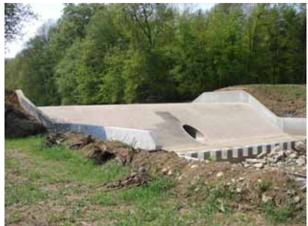
Abb. 4.3: Überlaufschwelle mit Durchlass, HRB Wallhausen.
