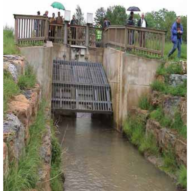
Abb. 5.27: Räumlicher Grobrechen beim HRB Raußmühle, Elsenz.
