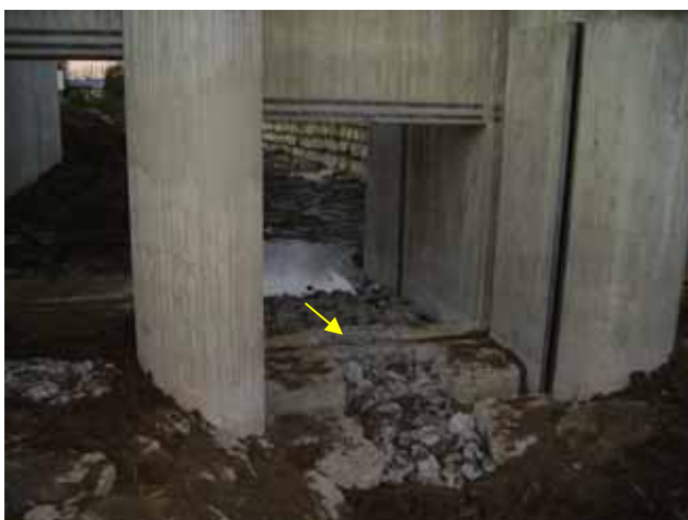
Abb. 5.8: Gabionen (gelber Pfeil) unter dem Schieber beim HRB Öhringen, Ohrn (im Bau).
