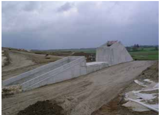
Abb. 7.11.3: HRB im Bau, offener und geschlossener Bereich des Durchlassbauwerks.
