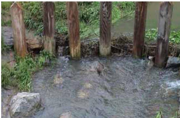
Abb. 3.6: Zugesetzter Vorrechen stellt eine Wanderbarriere dar.
