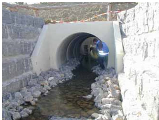
Abb. 5.11: Durchlassbauwerk im Bau HRB Steinsfurt, Insenbach.
