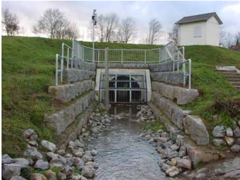
Abb. 7.3.3 : Teiloffenes Durchlassbauwerk mit räumlichen Rechen.
