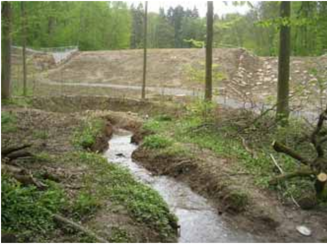
Abb. 7.17.3: Damm von Unterstrom; links Durchlassbauwerk Köpferbach, rechts Dammscharte zur Hochwasserentlastung.
