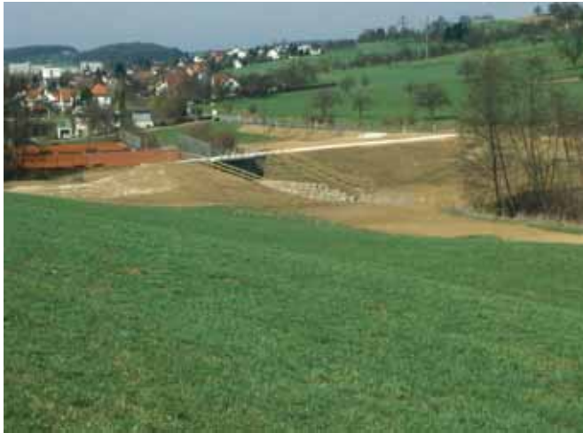
Abb. 7.6.3: Damm oberhalb Ortslage.
