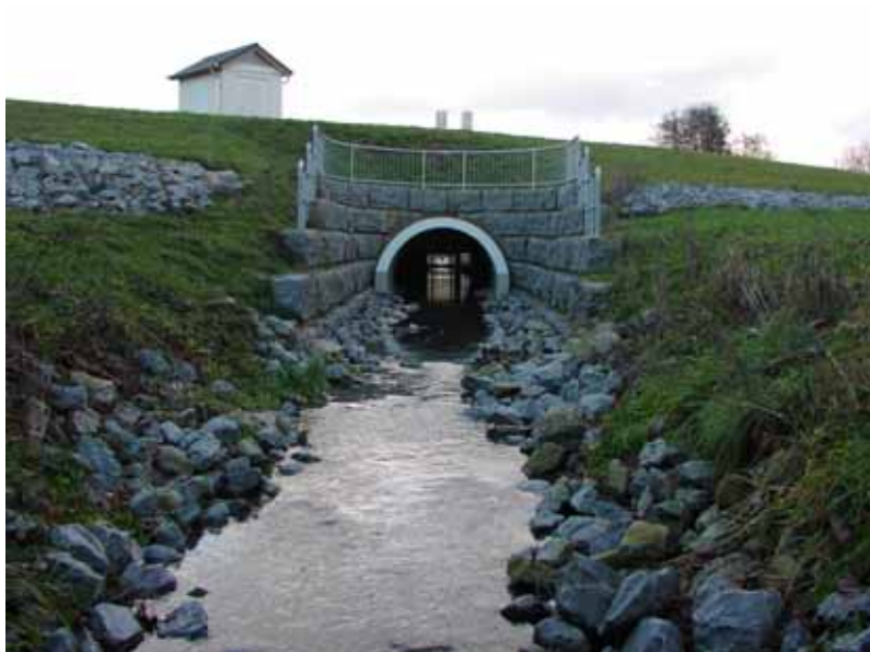
Abb. 7.3.6 : Teiloffenes Durchlassbauwerk von Unterwasser.
