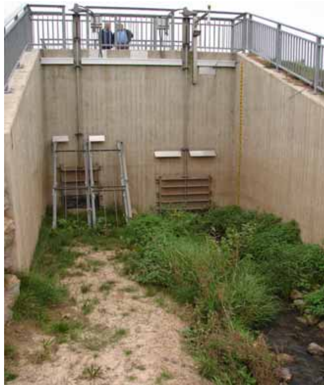
Abb. 5.3: Bewuchs bis an die Stauwand möglich beim HRB Neiperger Bächle, Wasserverband Zaber.
