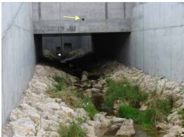
Abb. 7.11.4 Offener und geschlossener Bereich des Durchlassbauwerks mit Bruthöhle (gelber Pfeil).
