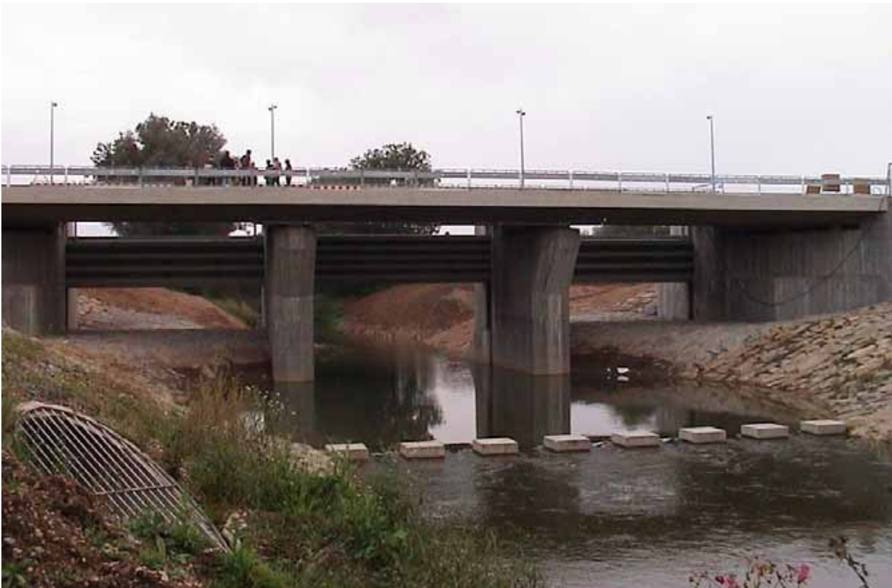
Abb. 7.15.5: Löffelartiges Tosbecken mit Zahnschwelle.
