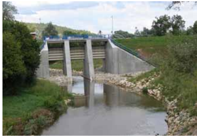
Abb. 3.7: Löffelförmiges Tosbecken HRB Reichenhof, Rems.
