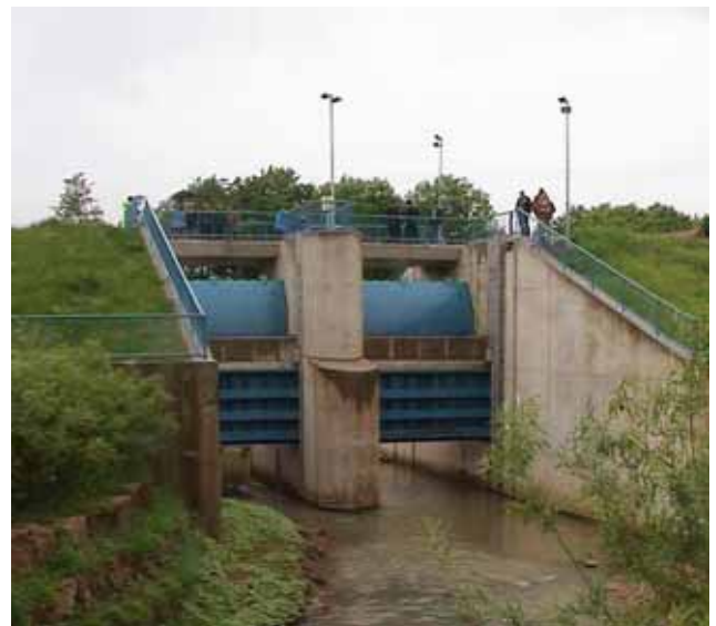
Abb. 5.22: HRB Bernau bei Waibstadt am Schwarzbach.
