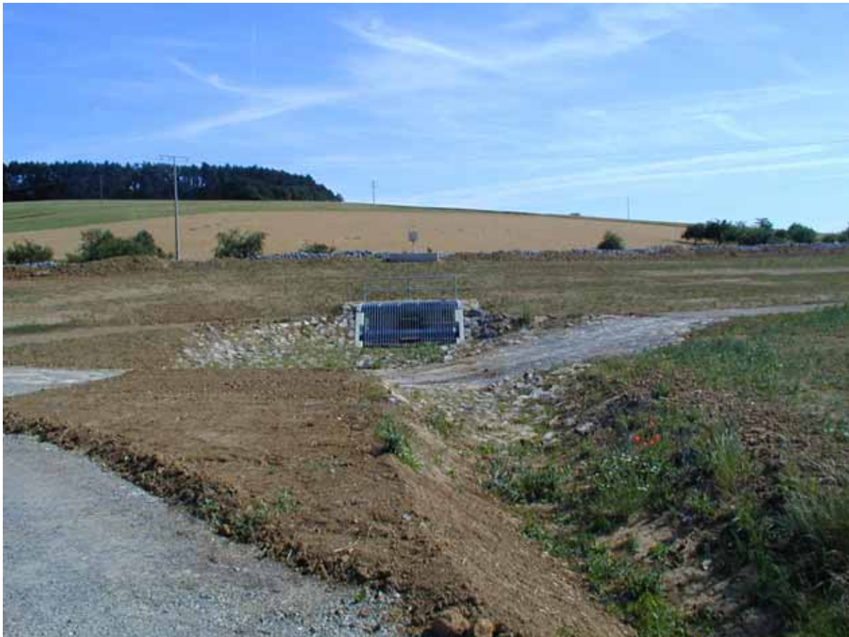
Abb. 7.5.4: Unterstrom, räumlicher Grobrechen.
