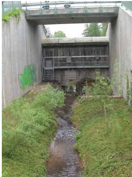
Abb. 7.1.3: Durchlassbauwerk von Unterwasser.
