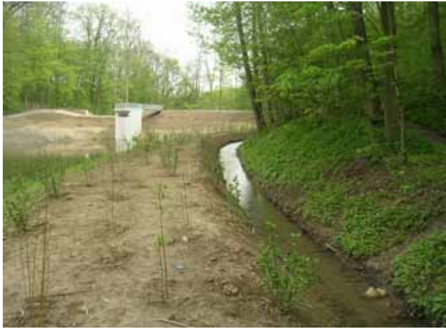
Abb. 7.17.4: Damm von Oberstrom; rechts im Bild: Umgebungsgewässer Köpferbach.
