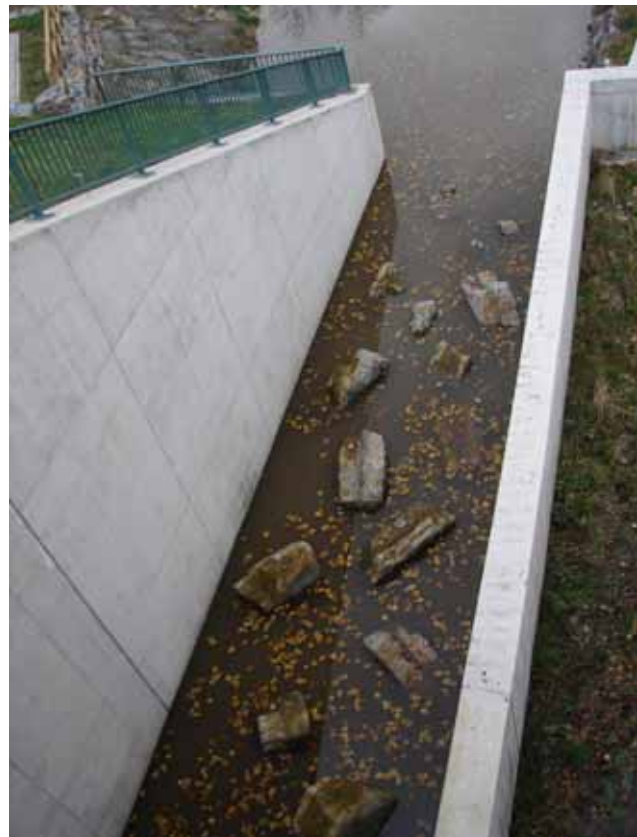
Abb. 5.25: Störsteine zur Energieumwandlung im Betriebsauslass HRB Halden, Brettach.
