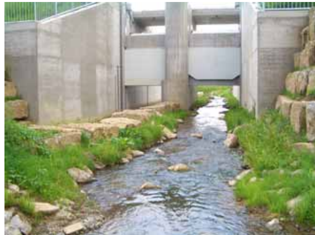
Abb. 5.18: Oberstrom rechts der Gewässerkorridor, links der Betriebsauslass beim HRB Oberes Wiesental, Schefflenz.
