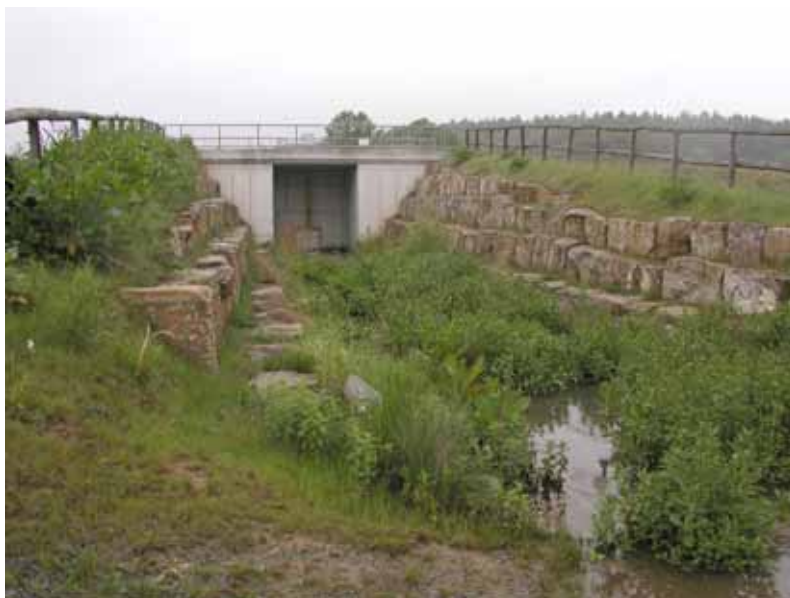
Abb. 7.4.4: Blick vom Unterwasser auf das Durchlassbauwerk.
