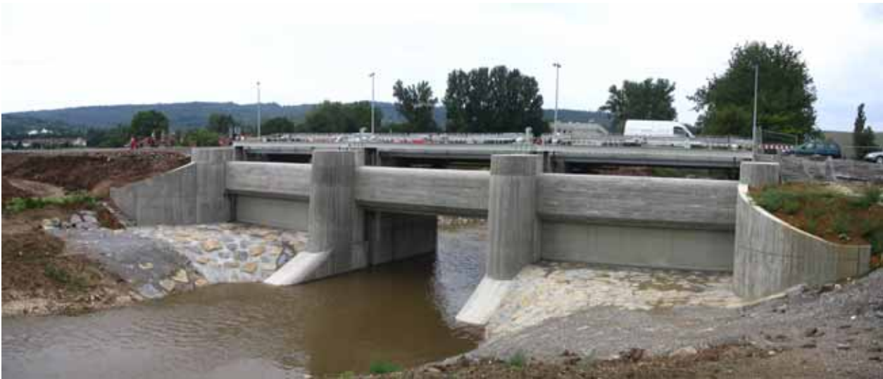
Abb. 7.15.4: Oberstrom mit abgesenkten Schütztafeln auf den Bermen.
