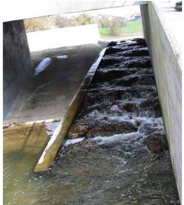
Abb. 6.2: HRB Seebach, Hochwasserentlastung mit Rauer Rampe (rechts) im Durchlassbauwerk.
