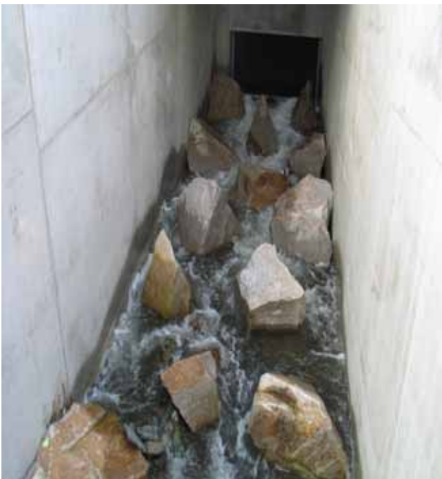
Abb. 5.29: Durchgängigkeitsbauwerk HRB Söllingen/Greffern, Rhein im Betrieb.
