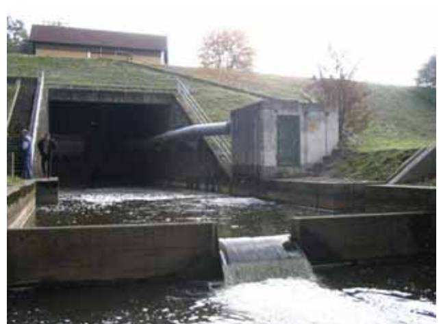
Abb. 3.5: Messwehr unterhalb einer Stauanlage.
