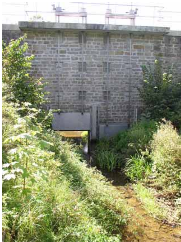
Abb. 7.6.5 : Damm von Unterstrom.
