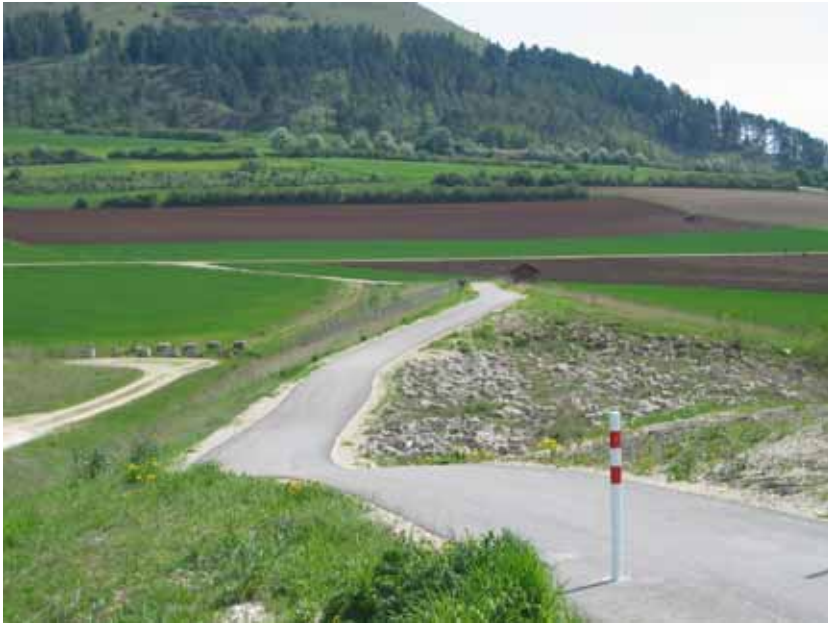
Abb. 7.9.3: Damm mit 50 m breiter Dammscharte (Hochwasserentlastung).
