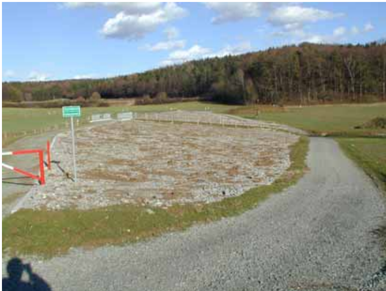
Abb. 7.4.3 :Ansicht des vollüberströmbaren Dammes.
