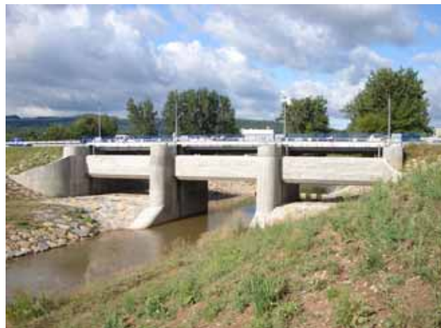
Abb. 5.5: Durchlassbauwerk HRB Winterbach, Rems.
