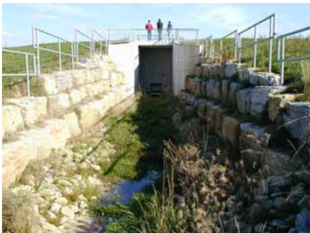
Abb. 5.7: HRB Asbach/Schwarzwiese (Neckar-Odenwald-Kreis) Blick vom Unterwasser in das Auslassbauwerk.
