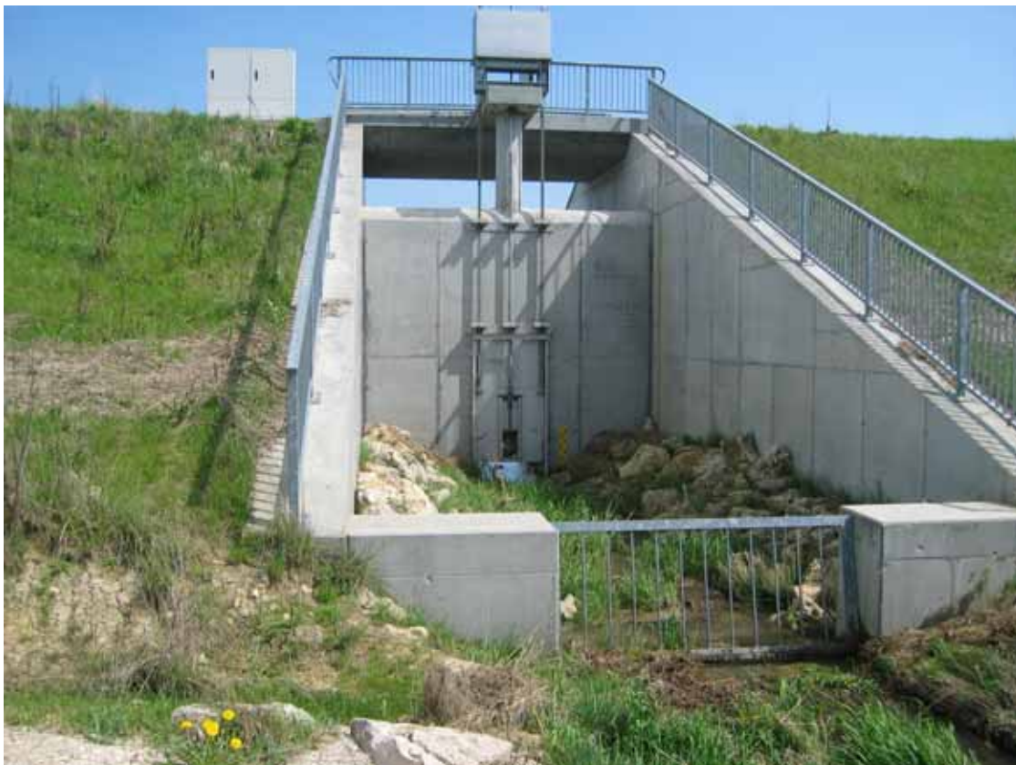
Abb. 7.7.4: Blick von Oberstrom.
