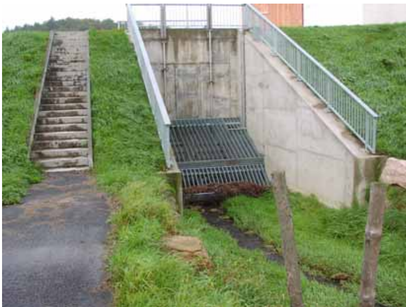
Abb. 7.2.4: Durchlassbauwerk mit räumlichen Rechen.
