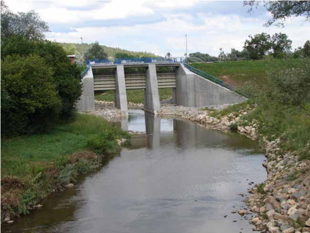
Abb. 7.14.2: Unterstrom HRB Nr.1 Reichenhof.
