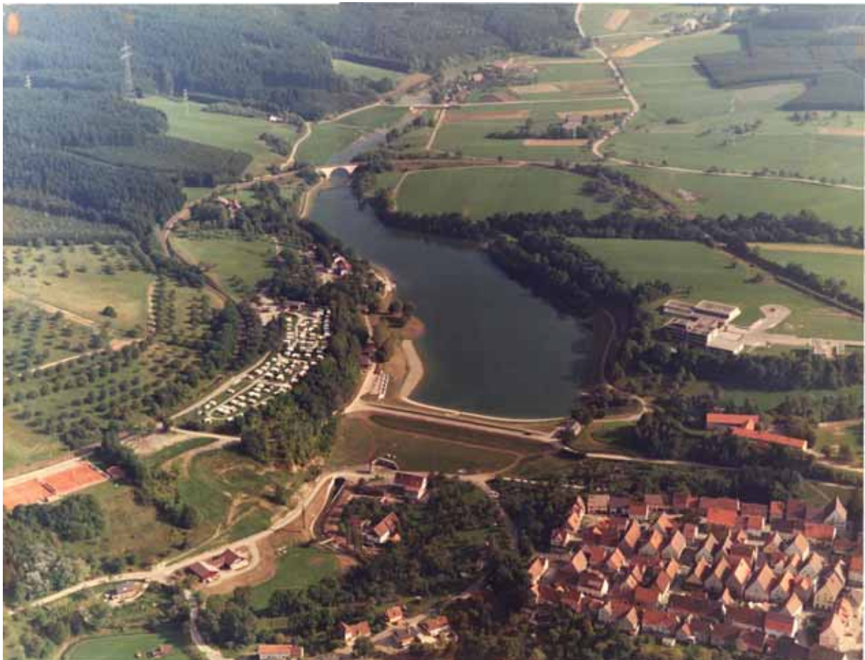
Abb. 1.1: Schlichemtalsperre bei Schömberg, keine Durchgängigkeit für Tiere im Gewässer.
