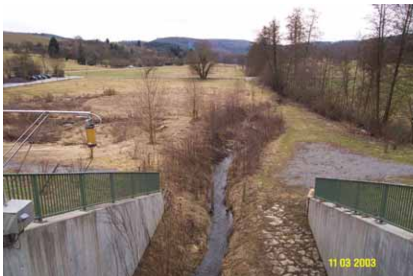
Abb. 7.1.5: Oberstrom Einlauf mit Grobrechen.
