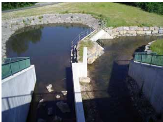
Abb. 7.10.4: Betriebsauslass (links), Ökogerinne (rechts).
