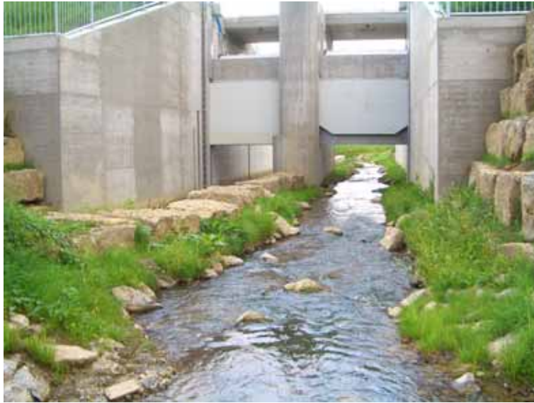
Abb. 7.13.3: Oberstrom, Schieberform (rechts) dem Gewässerbett angepasst.
