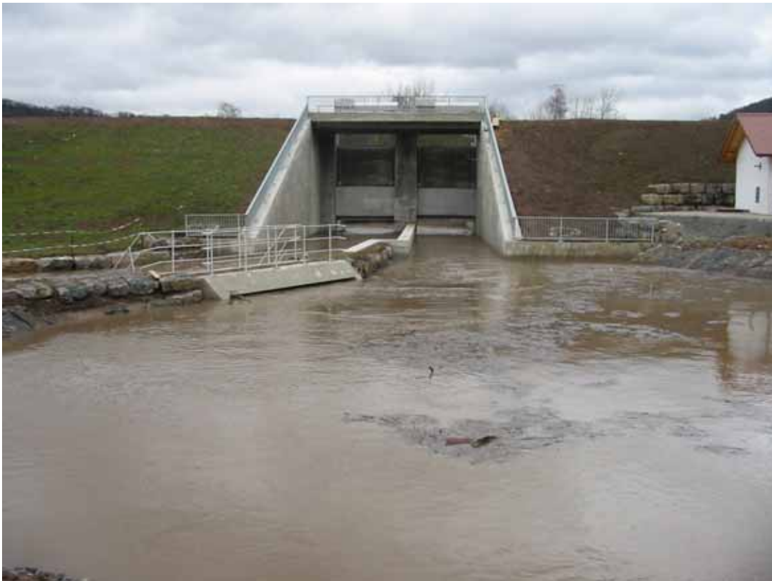
Abb. 7.10.2: Durchlassbauwerk von Unterwasser.
