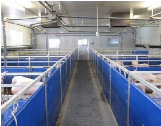
Abb. 5-13: Servicegang mit perforierten Bodenelementen, über welche konditionierte Frischluft aus Bodenkanälen unter dem Stall in den Tierbereich aufsteigt.
