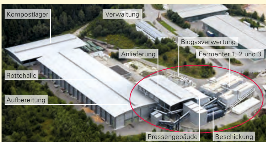
ABB. 9: UM EIN VERGÄRUNGSMODUL NACHGERÜSTETE KOMPOSTIERUNGSANLAGE IN PASSAU-HELLERSBERG (BUCHHEIT 2009)
