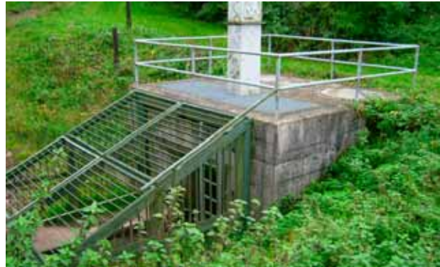
Abb. 6.9: Räumlicher Rechen und Notverschlüsse beim HRB Erlenbach
