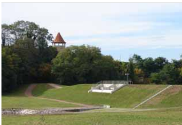
Abb. 1.1: HRB Heitersheim, Sulzbach (Trockenbecken)
