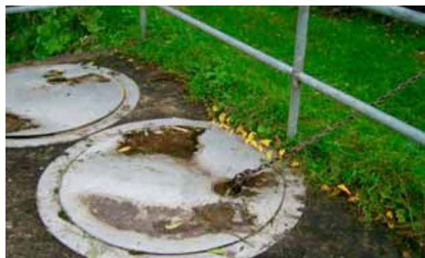
Abb. 6.11: Notverschluss mit Kette zum Öffnen
