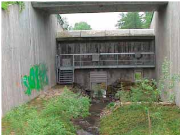
Abb. 6.6: Grundablass im Gewässerbett und Betriebsauslass auf der Uferberme (rechts) HRB Stadtseebach, Stadtseebach
