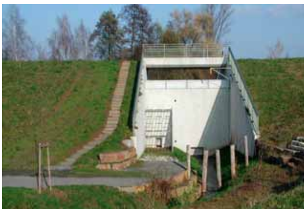
Abb. 6.1: Wasserseitige Ansicht des offenen Durchlassbauwerkes mit fester Überlaufschwelle, HRB Aubach
