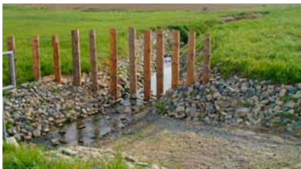
Abb. 6.8: Grober Vorrechen als Palisadenreihe
