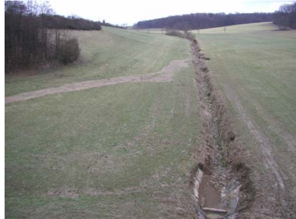
Abb. B.30: Links: HRB im eingestauten Zustand mit bräunlicher Hochwasserfarbe. Rechts: HRB-Stauraum nach dem Hochwassereignis. In der linken Bildmitte ist ein zurückgebliebener Spülsaum aus organischem Material zu erkennen. Der Bach ist sehr tief eingeschnitten und zeigt ebenfalls deutliche Erosionsspuren.
