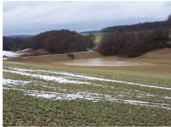
Abb. B.27: Links: Stauraum und Hochwasserdamm des HRB Seidelklingen. Rechts: HRB im Teileinstau.
