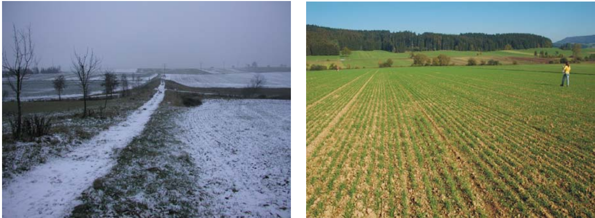
Abb. B.48: Links: Blick entlang des Hochwasserdammes des HRB Gunningen. Rechts davon ist ein Teil des Stauraumes zu sehen. Rechts: Detailansicht einer beprobten Ackerfläche und Blick in das Einzugsgebiet.
