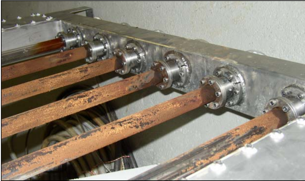
Abbildung 3-6 Getrocknete Beläge auf der Quarzglasröhroberfläche
