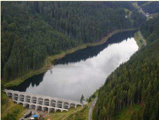
Linchtalsperre Vöhrenbach, www.voehrenbach.de
