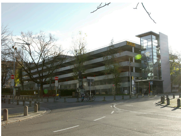
Abb. 3.4-6.: Bestand, Ansicht von Nordwest
