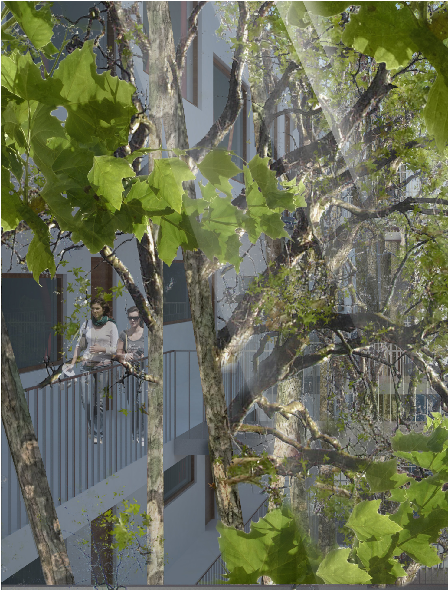
Abb. 3.2-21.: Blick durch die baubotanische Struktur des Laubengangs auf die gegenüberliegende Baubotanik an der Westfassade.
